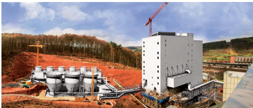
Kainit-Kristallisations-Flotations-Anlage (KKF-Anlage), K + S 2016
