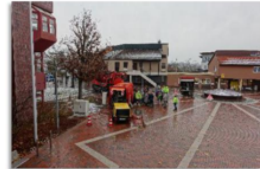
• Station 6 (Außenbereich / Parkplatz): Demonstration Kanalinspektion
