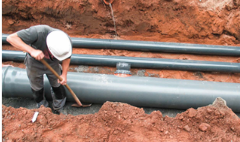
Für Sanierungen in offener Bauweise, wird der Boden aufgegraben.
