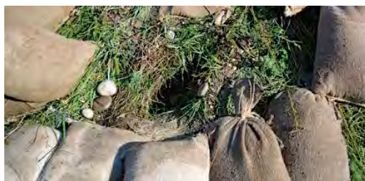
Abb. 53 (links unten): Wühlтиerbauten wie diese eingestürzte Biberdoline auf der Deichkrone müssen im Zuge der Überwachung erkannt und umgehend beseitigt werden. Die Deiche müssen hierzu in einem kontrollierbaren Zustand gehalten werden.
