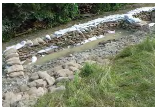
Abb. 34 (links): Fangedämme an großflächigen Austrittsstellen.
