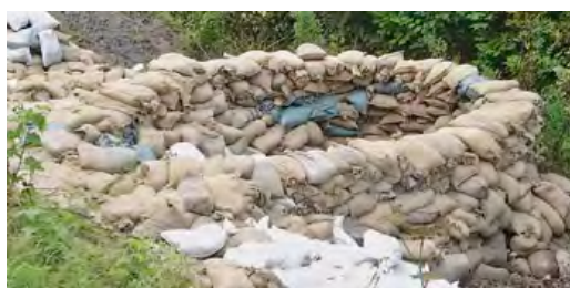
Abb. 37 (links): Auflastfilter oder Ringdamm
