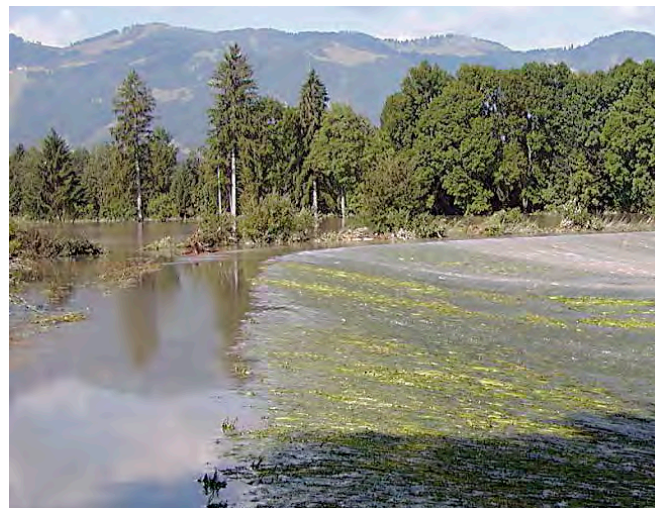
Abb. 23: Das Überströmen eines unbefestigten Deiches führt häufig zum Deichbruch. Rechtzeitige Evakuierung des Polders kann Leben retten.
