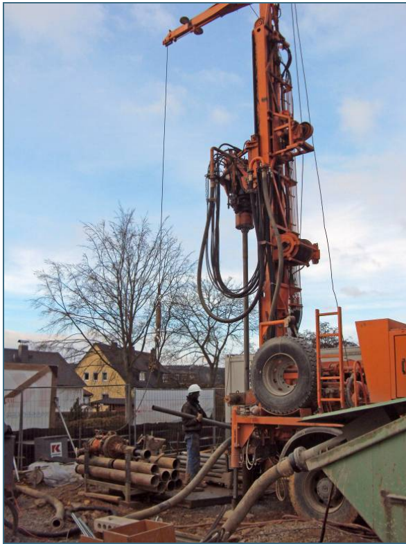
Abb. 2: Bohrung für Erdwärmesonden (Quelle: LfU)
