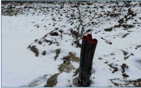
Abb. 8: Gesicherte Erdwärmesonde nach Abschluss der Zementation (Quelle: LfU)
