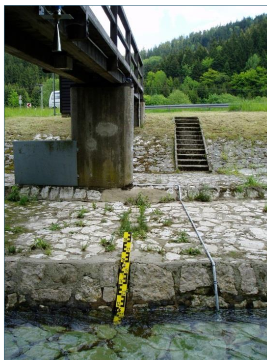
Abb. 1: Installation der Temperatursonde im Niedrigwassergerinne eines Pegels
