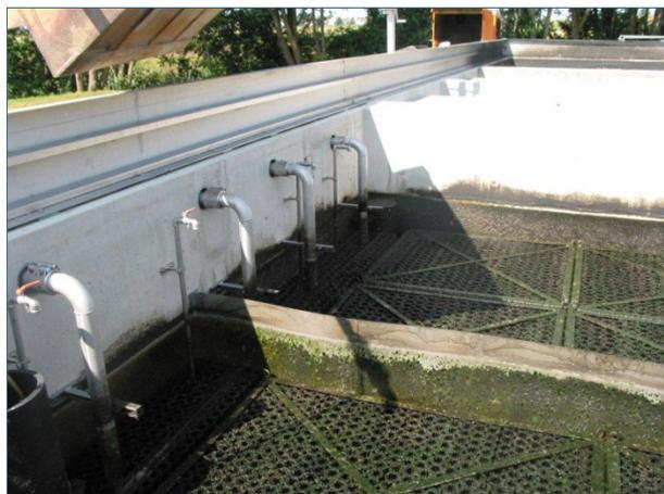
Abb. 15: Biologische Stufe mit getauchtem und belüfteten Festbett, entleert
