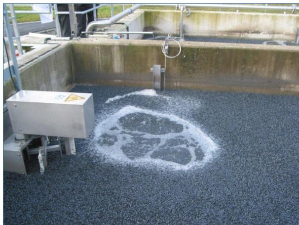
Abb. 16: Biologische Stufe mit freibeweglichen Aufwuchskörpern
