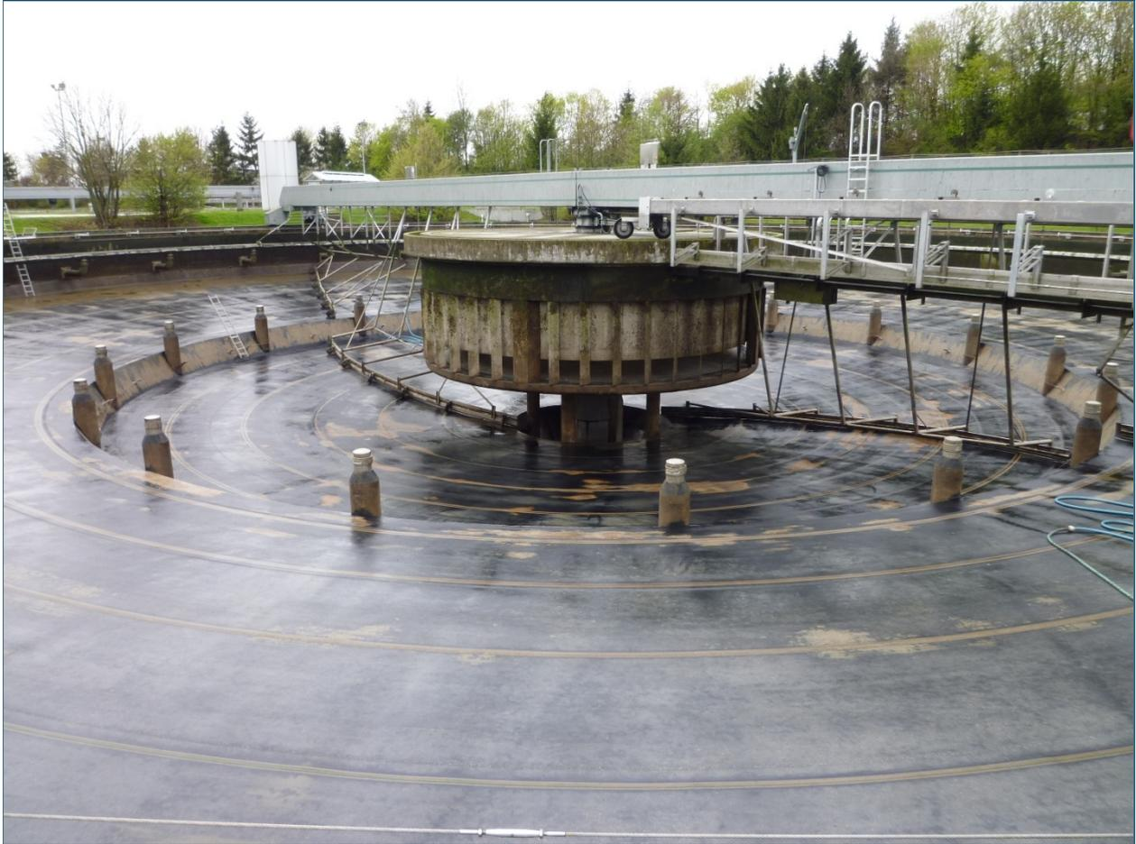
Abb. 7: Leeres Nachklärbecken: während das Wasser aus der Mitte des Beckens zum äußeren Rand fließt, setzt sich der Schlamm ab und wird von den Räumern in die innenliegende Vertiefung geschoben.
