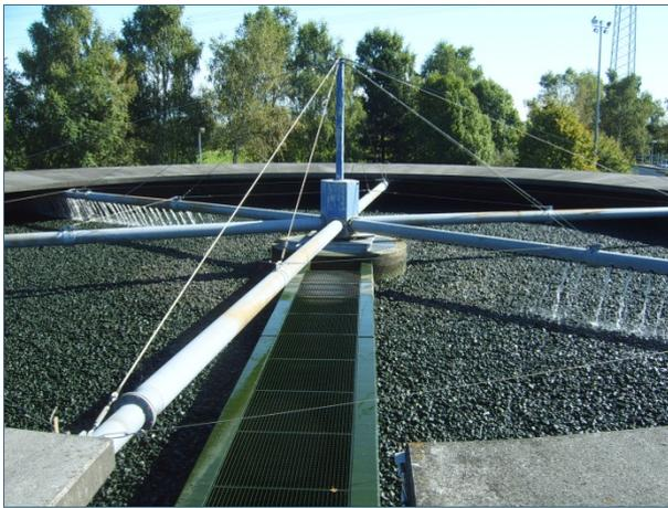
Abb. 10: Tropfkörper: der Drehsprenger verteilt das Abwasser gleichmäßig über der Schicht aus Lavabrocken.
