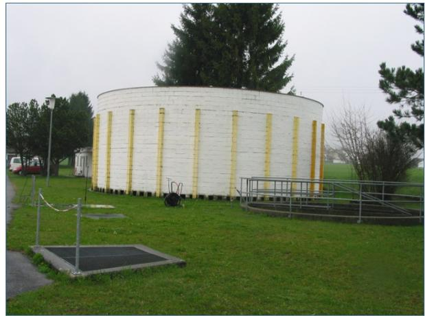
Abb. 11: Außenansicht eines Tropfkörpers
