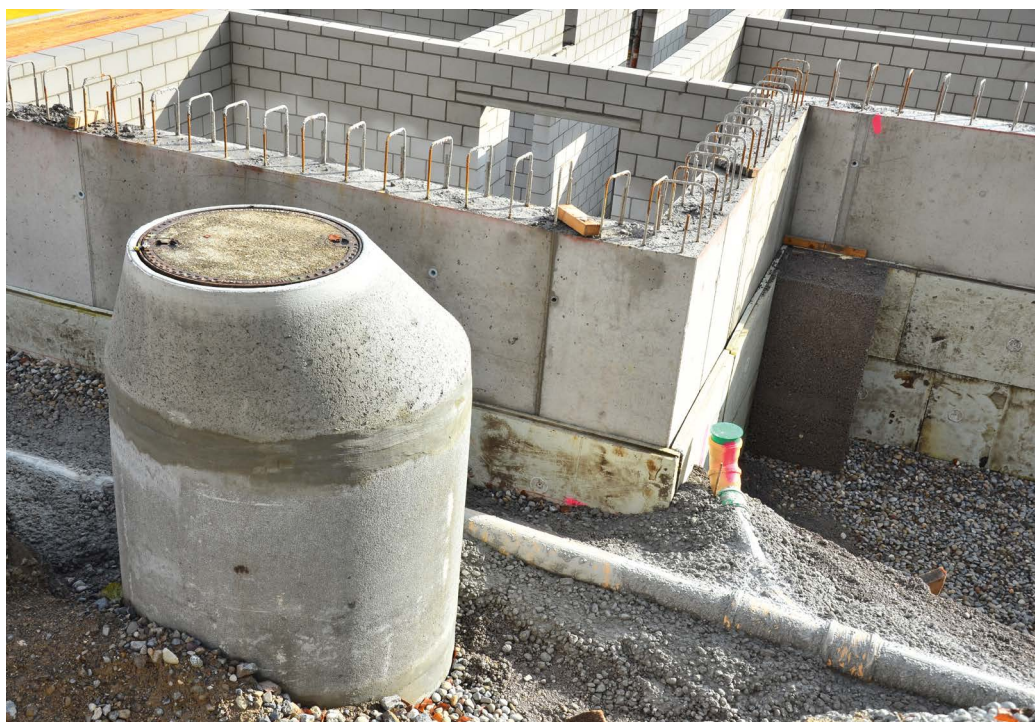
Abb. 1: Baustelle mit Grundstücksentwässerungsanlage
