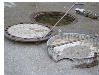
Abb. 21: Gut erreichbarer Revisionschacht (mit Kanal-kamera)
