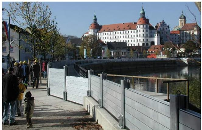
Abb. 2: aufgebaute mobile Hochwasserschutz Elemente in Neuburg an der Donau. Quelle: Wasserwirtschaftsamt Ingolstadt.
