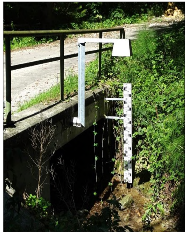
Abb. 1: Praxisbeispiel Markt Peißenberg; Wasserstandsmesser im Wörthersbach. Quelle: Markt Peißenberg
