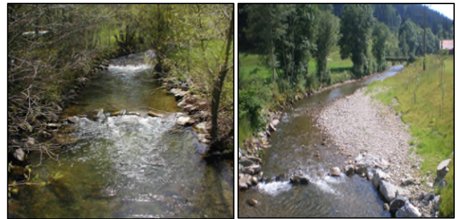
Abb.2: Praxisbeispiel Markt Weitnau; Gewässerbettaufweitung (links: vorher, rechts: nachher). Quelle: WWA KE.
