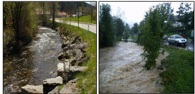
Abb. 1: Praxisbeispiel Markt Weitnau; Links: vor Ausbau – normaler Abfluss, rechts: vor Ausbau – Hochwasser August 2005. Quelle: WWA KE.
