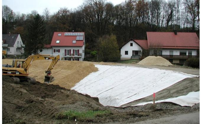
Abb. 1: Beispiel von Arbeiten zur Deichsanierung. Quelle: LfU.
