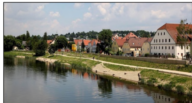
Abb. 2: Praxisbeispiel Regensburg; Hochwasserschutzmauern am Ufer des Regens im Stadtteil Reinhausen. Quelle: Wasserwirtschaftsamt Regensburg
