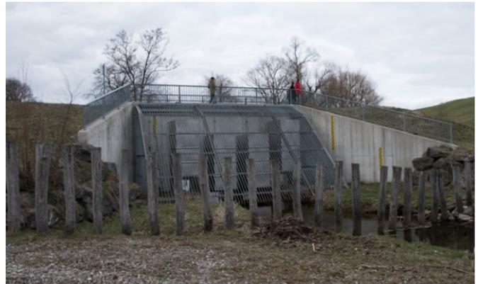
Abb. 1: Treibgutrechen (mit entferntem Material im Vordergrund) vor dem frisch gemähten Damm mit Drosselbauwerk am Hochwasserrückhaltebecken Thalhofen des Zweckverbandes. Quelle: LfU
