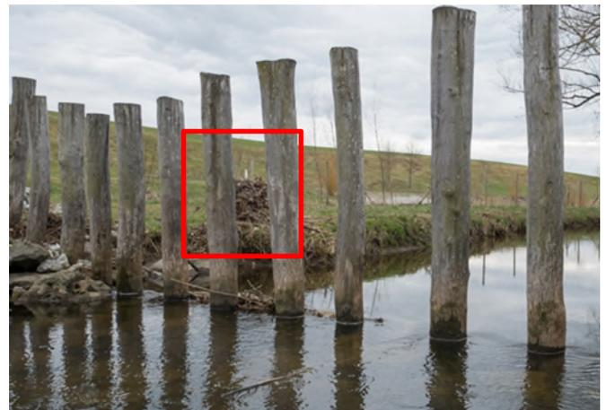
Abb. 2: Treibgutrechen an einer Hochwasserrückhaltemaßnahme des Zweckverbandes. Im Hintergrund: Aus dem Rechen entferntes Material vor dem Abtransport (rote Markierung). Quelle: LfU
