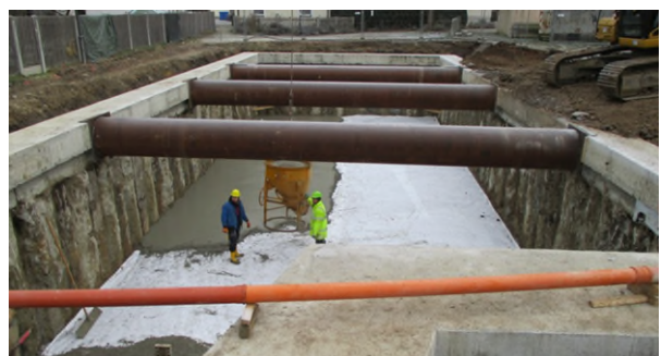
Abb. 3: Bau eines Rückhaltebeckens zur Regenwasserentlastung (Beispielbild), Quelle: Wasserwirtschaftsamt Regensburg
