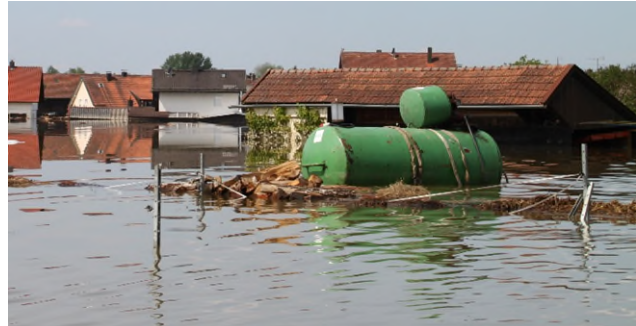
Abb. 1: Aufgeschwommener Dieseltank einer Eigenverbrauchstankstelle beim Hochwasser 2013. Quelle: Wasserwirtschaftsamt Deggendorf.
