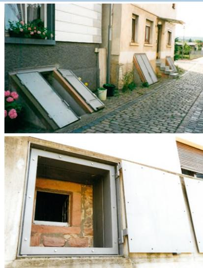
Abb. 2: Objektschutzmaßnahmen (oben: Abdichtung eines Kellerabgangs, unten: Abdichtung von Fenstern), die auch zu Demonstrationszwecken genutzt werden können. Quelle: LfU.
