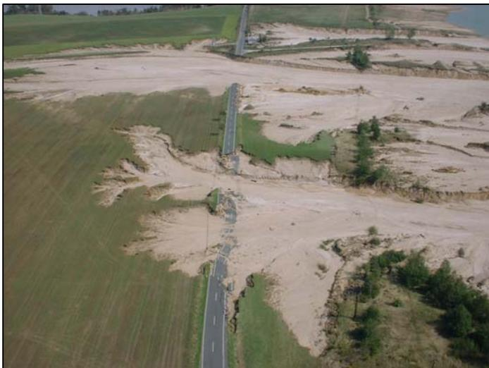
**Abbildung 10: Hochwasserschäden an Bahngleisen und Bundesstrassen**
