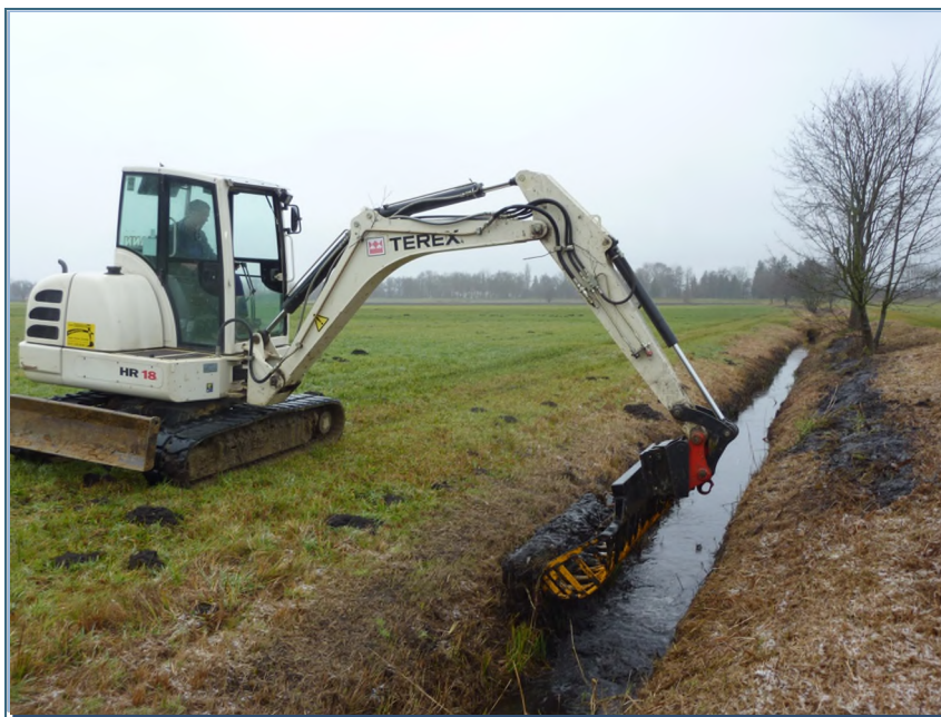
Abb. 19: Arbeiten an der Gewässersohle stellen einen erheblichen Eingriff in das Gewässer dar
