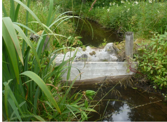
Einstau mit Holz
