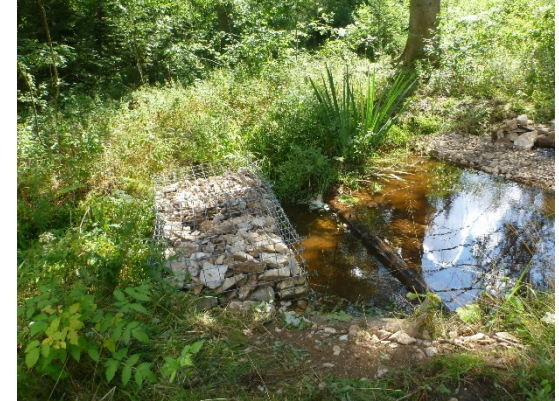
„Staustufe“ aus Gabionen/Holz
