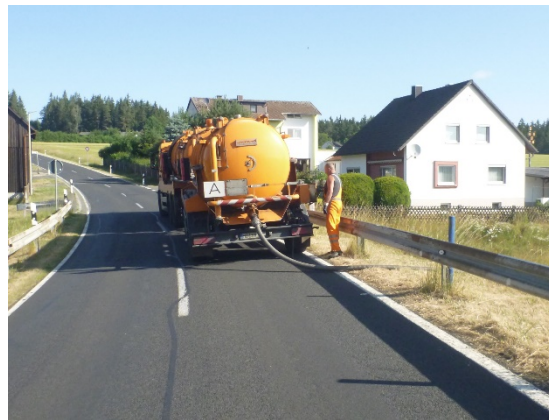
Einspeisen aus Tank-LKW
