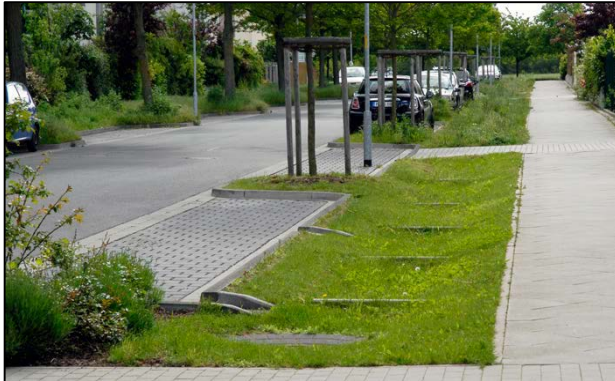
Muldenkaskaden zur Versickerung von Straßenabflüssen
