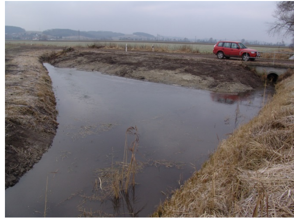
Abb. 11: Fertiges Absetzbecken
