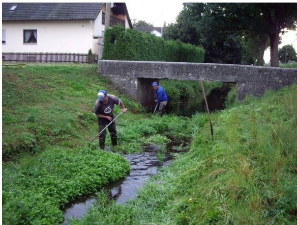
Abb. 8: Zeitaufwändiger, aber dafür eine sehr schonende Methode: Sohlkrautung mit der Handsense
