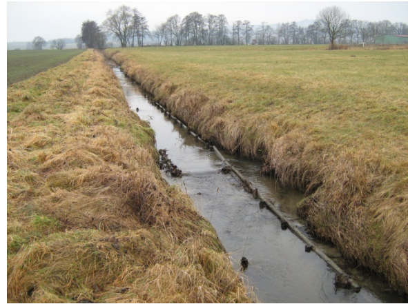
Abb. 3: Grabenartig ausgebautes Fließgewässer
