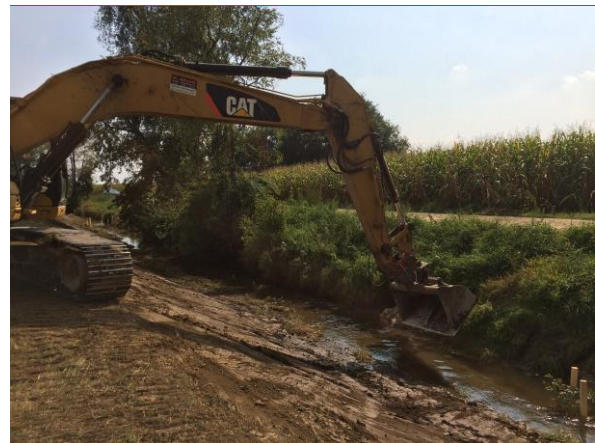
Abb. 17: Abflachung von Uferbereichen und punktueller Einbau von Störelementen
