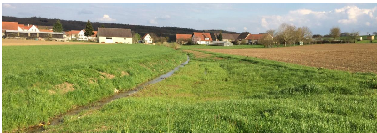
Abb. 15: Fertiggestelltes Absetzbecken am Nebelbach, Gemeinde Lutzingen
