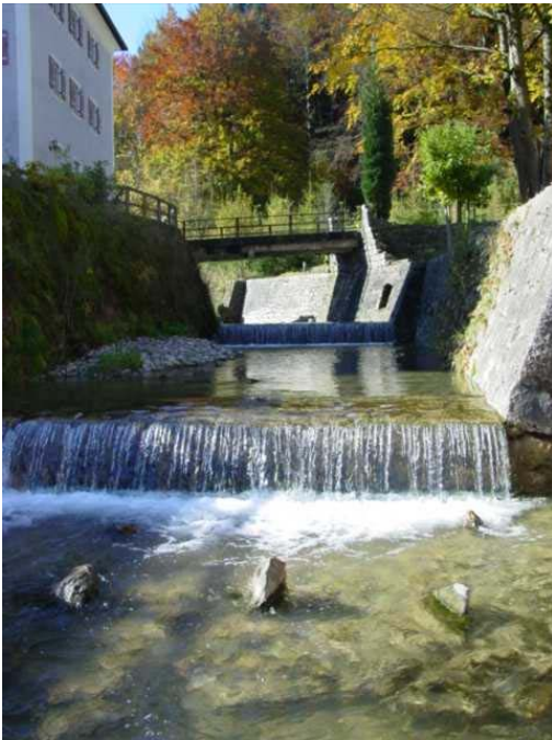
Abb. 20: Oberteisendorfer Ache, Bild WWA TS Durch Sohlswellen und Ufermauern verbautes Gewässer
