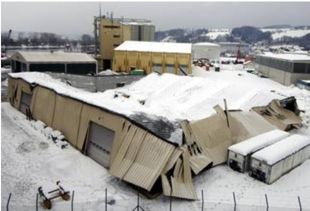
Abbildung 1 Das Dach einer Gewerbehalle ist durch Schneemassen eingedrückt worden
