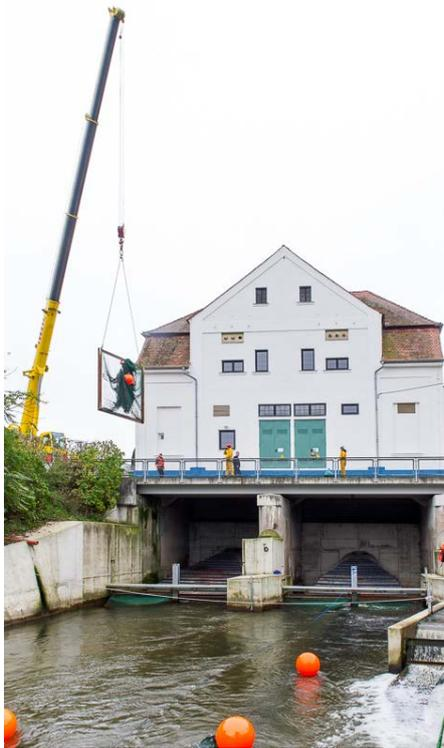
Abb. 2: Einheben eines Stahlrahmens mit Hamen durch Autokran
