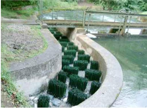
Abb. 26: Technische Fischaufstiegsanlage: Bürstenpass
