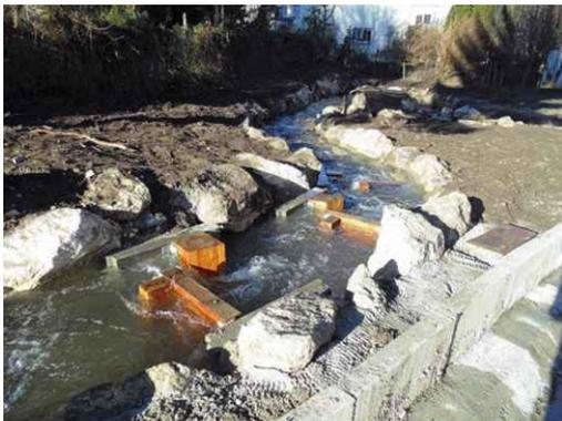
Abb. 28: Technische Fischaufstiegsanlage: Vertical-Slot-Pass
