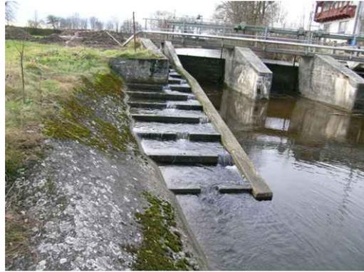
Abb. 27: Technische Fischaufstiegsanlage: Beckenpass
