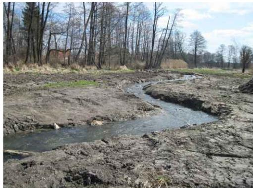
Abb. 31: Naturnahe Fischaufstiegsanlage: Umgehungsbach (kurz nach der Fertigstellung)
