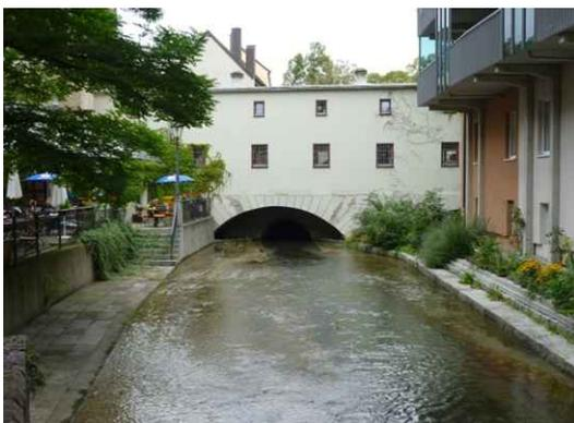
Abb. 24: Verrohrung unter einer flächenhaften Überbauung (Gebäude)
