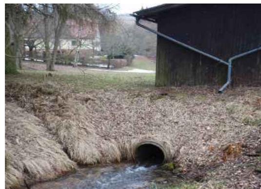
Abb. 25: Verrohrung unter einer flächenhaften Überbauung (Nutzfläche)
