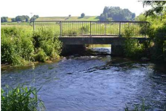
Abb. 22: Betonierter Durchlass an einer Wegunterführung
