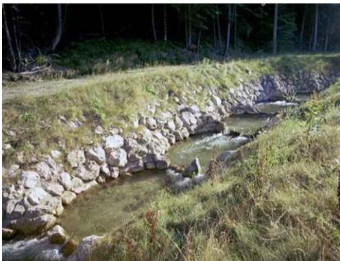
Abb. 30: Naturnahe Fischaufstiegsanlage: Tümpelpass (naturnaher Beckenpass)
