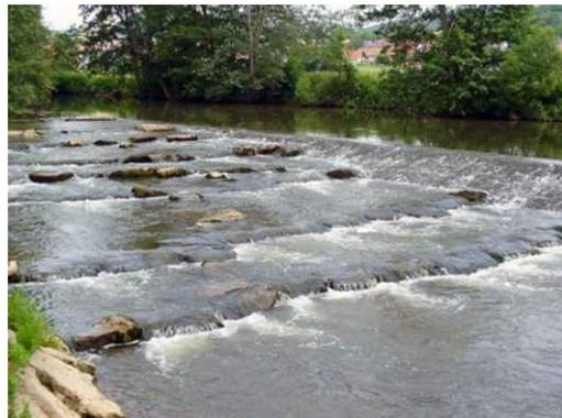
Abb. 29: Naturnahe Fischaufstiegsanlage: Raue Rampe bzw. raue Gleite (mit Beckenstruktur)
