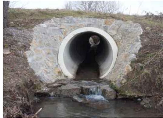
Abb. 23: Betonrohr als Durchlass an einer Wegunterführung
