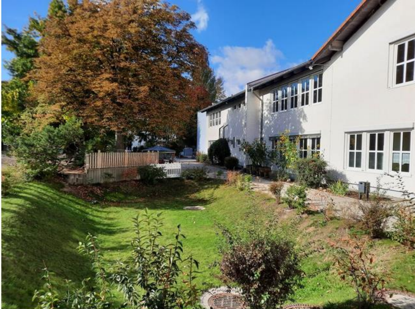
Multifunktionale Regenwasserrückhalte- und Versickerungsanlage Regenbogenschule Taucha
