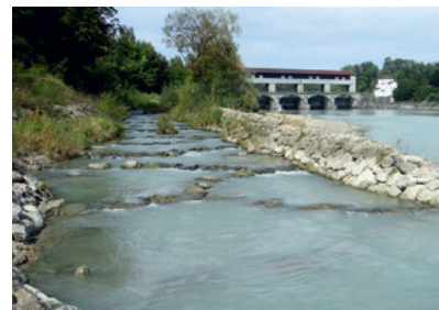
Fischaufstiegshilfe, Wehranlage am Inn
