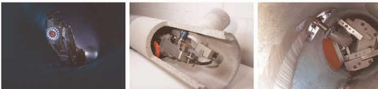
Auch für kleinere Reparaturarbeiten im Rohr können bestimmte Kanalroboter eingesetzt werden. Mit speziellem Werkzeug fräst und spachtelt der ferngesteuerte Roboter direkt im Rohr.
