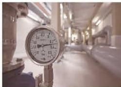
Trinkwasserleitungen stehen ständig unter Druck und können aus hygienischen Gründen zum Prüfen nicht einfach geöffnet werden.
