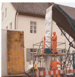
Ein mit Herz getränkter Schlauch wird in das alte Abwasserrohr eingezo-gen.
