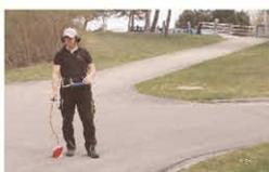
**Alles dicht?** Rasche erste Hilfe bei Rohrbrüchen gehört ebenso zu deinen Aufgaben, wie das Aufspüren versteckter Lecks mit Hilfe von akustischen Sensoren.
