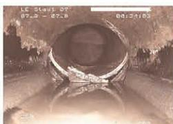
Ein Rohrbruch im Kanal kann schwerwiegende Folgen haben. Schadstoffe gelangen in den Boden. Außerdem kann Grundwasser ins Kanalnetz eindringen und dieses unnötig belasten. Pumpkosten und der Aufwand für die Abwasserbehandlung steigen dadurch.
