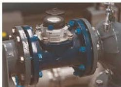
Wasserversorger messen daher Wasserverluste, indem sie die Einspeisungsmengen mit der an den Endverbraucher gelieferten Menge vergleichen.
