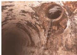
Ist der Kanal auf dem Grundstück oder der Anschluss ans Kanalnetz mangelhaft, kann das negative Auswirkungen auf das gesamte Kanalnetz haben. Durch schadhafte Anschlüsse kann etwa Grundwasser in das öffentliche Kanalnetz eindringen und dieses unnötig belasten.
