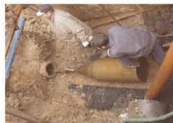
Beim Berstlining wird eine Berstmaschine unter der Erdoberfläche durch das alte Rohr gezogen.
