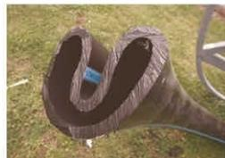
Beim Close-Fit-Lining wird ein gefaltetes Kunststoffrohr in das bestehende alte Rohr eingezogen.
