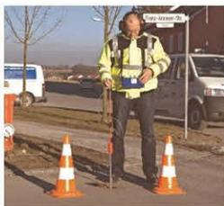
Um ein Leck in der Leitung zu orten, greifen Trinkwasserversorger zum Beispiel zu „Abhörgeräten“. Durch die Leckgeräusche lässt sich der Schaden aufspüren.
