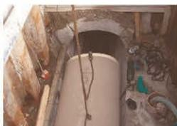
Kurze Rohrteile werden hintereinander ins alte Rohr geschoben oder gezogen.
