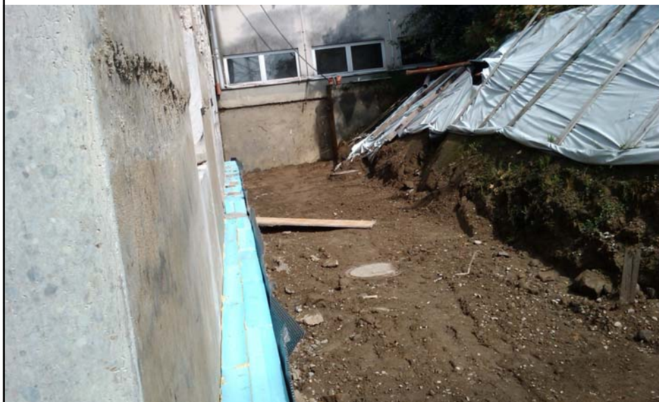
Dämmmaterial 1,5 m im Boden 30 cm stark
