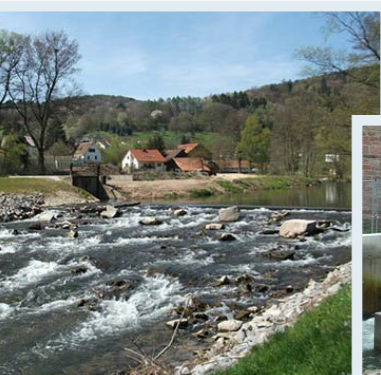
Abb. 1: Die raue Rampe an der Lohr stellt die biologische Durchgängigkeit wieder her (links); die neue Wasserkraftschnecke sorgt für eine ausreichende Wasserführung (rechts).
