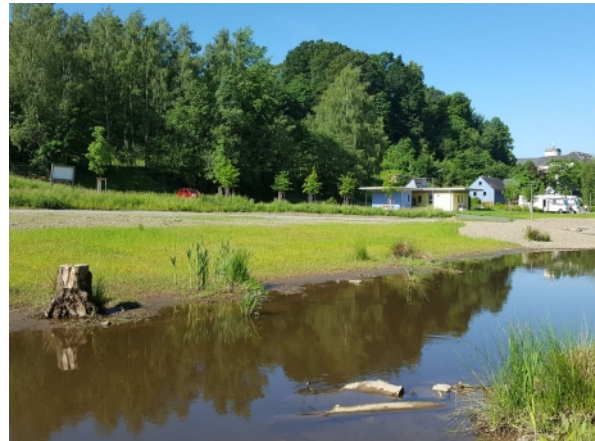
Abb. 161: Nachher: Städtisches Naherholungsgebiet mit zugänglichen Ufern und einer begehbaren Insel im Fluss (Schwesnitz in Oberkotzau, Oberfranken)
