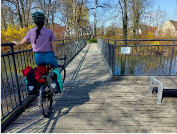
Abb. 25: Geh- und Radwegbrücke in einem Naherholungsgebiet (Brenz in Gundelfingen a.d.Donau, Schwaben)
