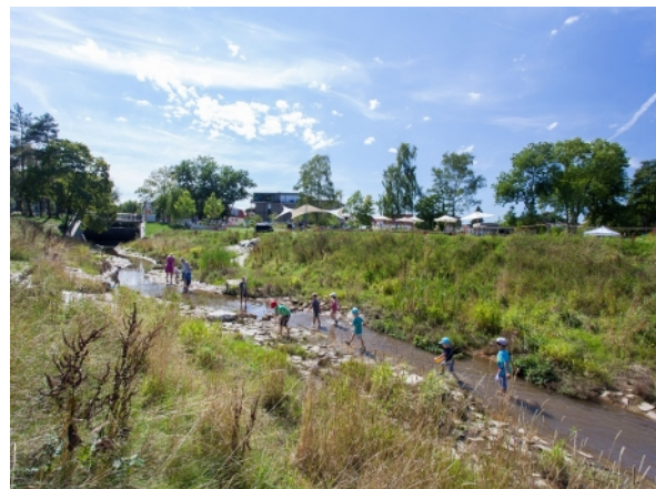
Abb. 141: Nachher: Attraktive Grünanlage mit zugänglichem Gewässer nach der Umsetzung (Ilm in Pfaffenhofen a.d.Ilm, Oberbayern)
