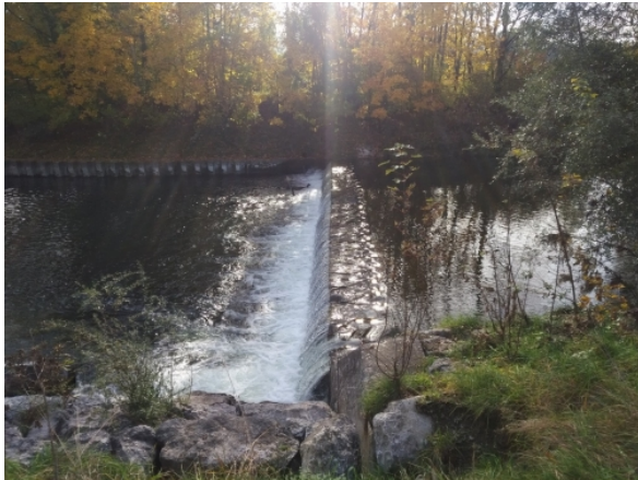
Abb. 138: Vorher: Lebensgefährlicher Betonabsturz vor dem Umbau zur Herstellung der biologischen Durchgängigkeit (Mangfall in Rosenheim, Oberbayern)
