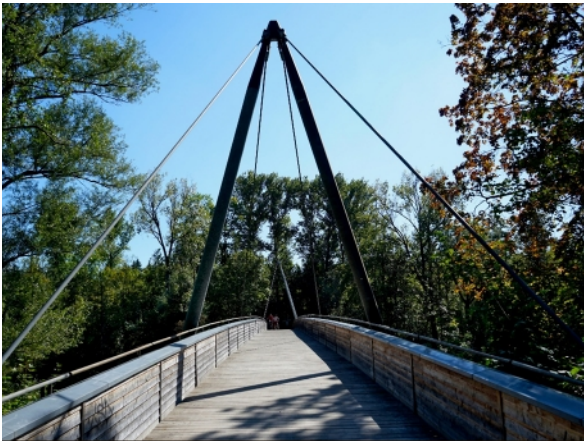
Abb. 27: Geh- und Radwegbrücke von Gehölzen der Flussaue umgeben (Isar in Ismaning, Oberbayern)
