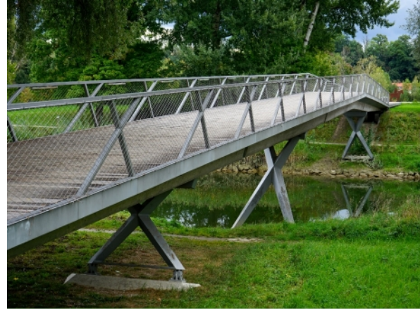
Abb. 26: Hochwasserangepasste Brückenkonstruktion auf dem ehem. Gelände der Landesgartenschau (Mangfall in Rosenheim, Oberbayern)
