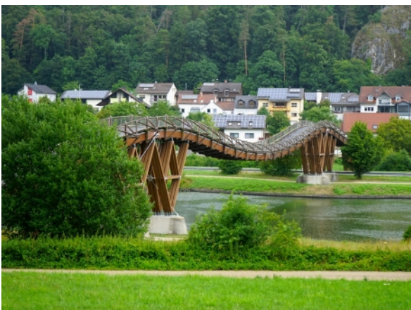
Abb. 29: Geschwungene Fußgängerbrücke „Tatzlwurm“ (Altmühl in Essing, Niederbayern)
