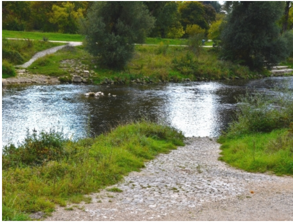
Abb. 39: Gepflasterte Rampe zum Wasser (Wertach in Augsburg, Schwaben)
