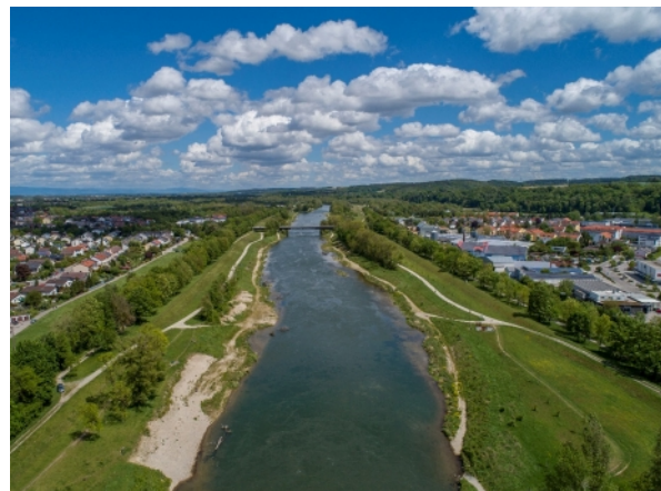
Abb. 163: Nachher: Der renaturierte Fluss und seine zugänglichen Ufer sind wieder ein Teil der Stadt (Isar in Dingolfing, Niederbayern)
