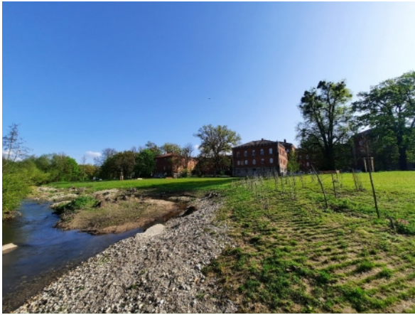
Abb. 5: Uferabflachung, Kieseinbringung und Gehölzpflanzungen am Ufer (Bogenbach in Deggen-dorf, Niederbayern)
