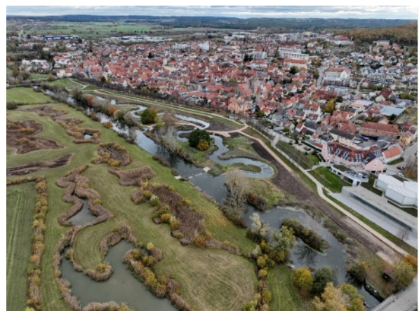
Abb. 157: Nachher: Ein neuer Seitenarm, verschlungene Pfade und Rastplätze binden den Fluss wieder ins Stadtbild ein (Altmühl in Gunzenhausen, Mittelfranken)
