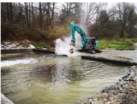
Abb. 9: Rückbau eines Querbauwerks zur Sohlgleite (Isen in Winhöring, Oberbayern)
