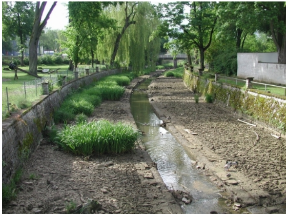
Abb. 144: Vorher: Technisches Gerinne mit begrenzenden Ufermauern im abgelassenen Zustand vor Baubeginn (Sulz in Beilngries, Oberbayern)
