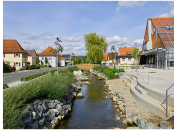
Abb. 6: Freilegung und naturnahe Gestaltung eines verrohrten Mühlbachs im Ortskern (Alte Weis-main in Altenkunstadt, Oberfranken)
