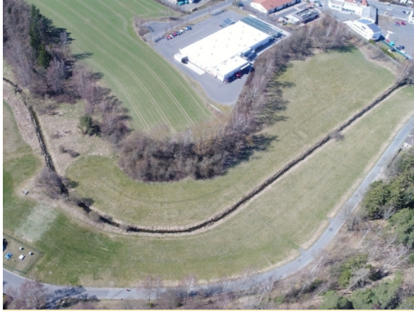
Abb. 142: Vorher: Begradigter Bachlauf vor der Renaturierung (Selb in Selb, Oberfranken)
