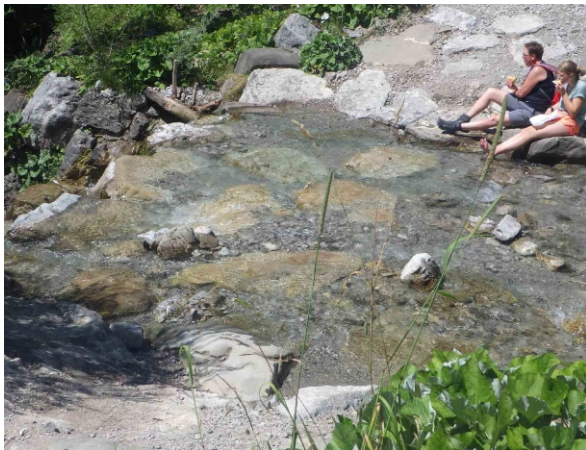
Abb. 21: Furt mit großem Steinsatz im ausgebauten Wildbach (Faltenbach in Oberstdorf, Schwaben)
