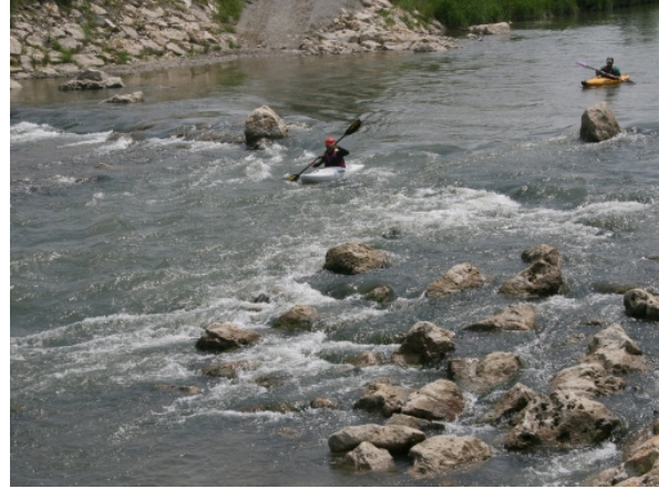
Abb. 12: Vollständiger Umbau eines Wehres zur passierbaren Sohlgleite (Ammer in Weilheim, Oberbayern)
