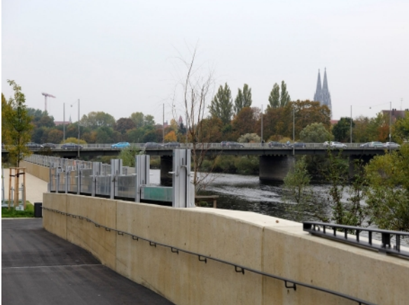
Abb. 57: Mobiles Hochwasserschutzsystem (Regen in Regensburg, Oberpfalz)
