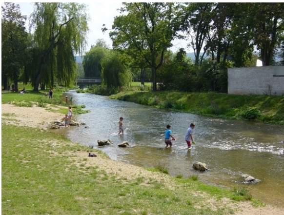
Abb. 1: Rückbau von Ufermauern, Abflachung des Ufers und Aufweitung des Gewässerbettes (Sulz in Beilngries, Oberbayern)
