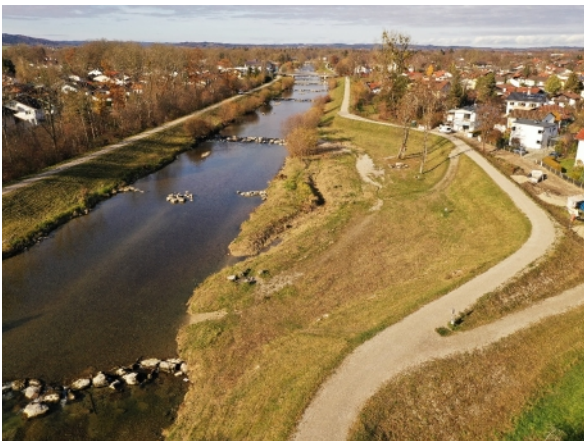
Abb. 59: Kleinräumige Rückverlegung eines Deichs mit Deichkronenweg (Mangfall in Bad Aibling, Oberbayern)
