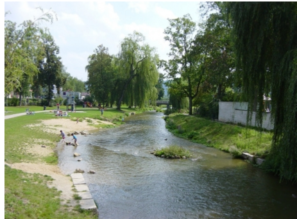
Abb. 145: Nachher: Naturnahes Gewässer mit zugänglichem Ufer und Flachwasserbereichen nach der Renaturierung (Sulz in Beilngries, Oberbayern)
