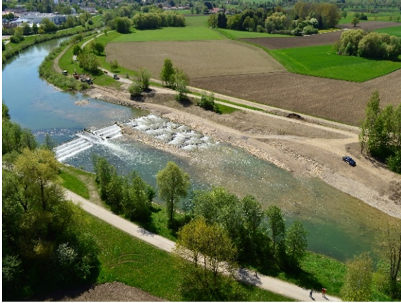
Abb. 11: Halbseitiger Umbau eines Wehres zur Riegel-Sohlgleite inklusive Uferumgestaltung (Ammer in Weilheim, Oberbayern)
