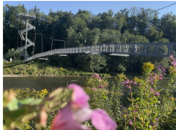
Abb. 28: Hängebrücke mit Beobachtungsturm am Kraftwerk Legau (Iller in Legau, Schwaben)
