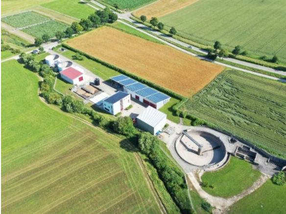
Abb. 136: Kläranlage mit Membranbelebungsanlage (Gailach in Monheim, Schwaben)
