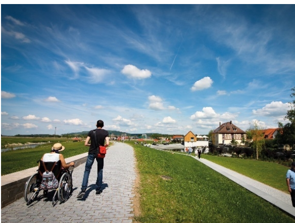
Abb. 89: Deichunterhaltungswege in Siedlungsnähe zur Nutzung freigegeben (Wörnitz in Wassertrüdingen, Mittelfranken)
