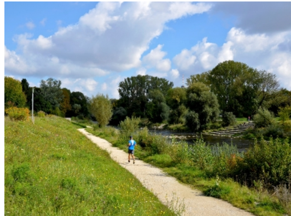
Abb. 167: Nachher: Eine Deichrückverlegung ermöglicht ufernahe Wege und attraktive Aufenthaltsmöglichkeiten am Fluss (Wertach in Augsburg, Schwaben)
