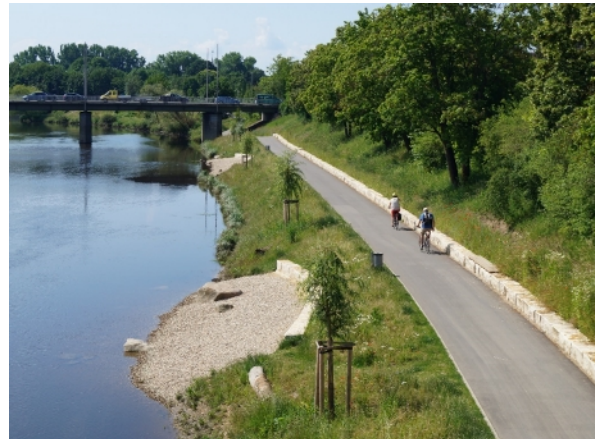
Abb. 88: Neuer Geh- und Radweg im Rahmen des Hochwasserschutzes (Regen in Regensburg, Oberpfalz)
