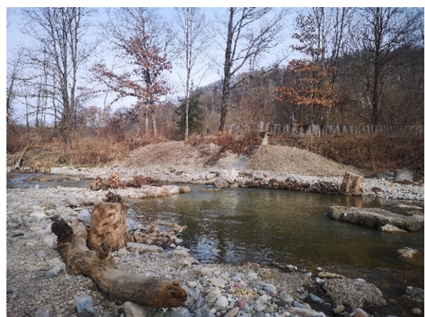
Abb. 10: Naturnahe Gestaltung nach dem Rückbau mit Flachwasserbereichen und Kiesbänken (Isen in Winhöring, Oberbayern)
