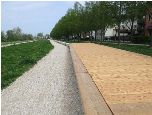
Abb. 79: In den Hochwasserschutz integrierte Sitzgelegenheit (Altmühl in Gunzenhausen, Mittelfranken)
