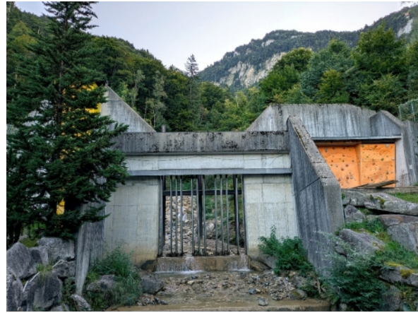
Abb. 118: In die Mauer einer Wildbachsperre integrierte Kletterwand (Altdorfbach in Vitznau, Schweiz)
