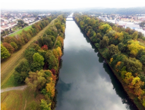
Abb. 162: Vorher: Strukturarmes und von der Stadt getrenntes Gewässer vor Maßnahmenbeginn (Isar in Dingolfing, Niederbayern)
