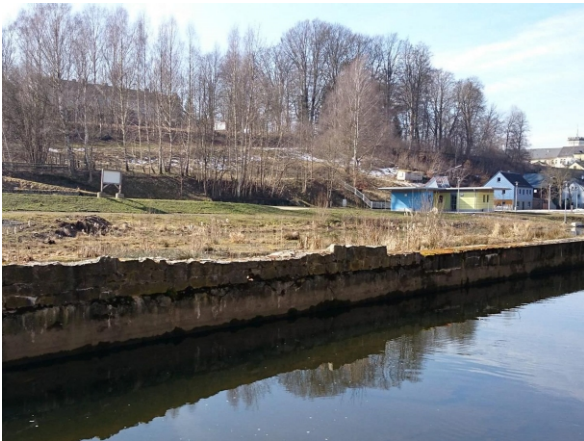
Abb. 160: Vorher: Naturferner Gewässerzustand mit Uferverbau vor der Renaturierung (Schwesnitz in Oberkotzau, Oberfranken)
