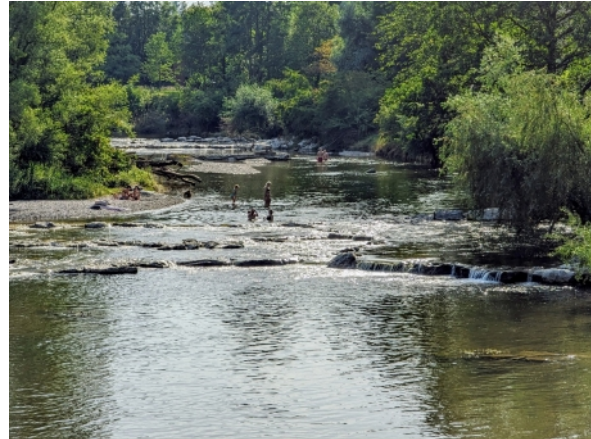
Abb. 139: Nachher: Vom Umbau des Querbauwerks profitiert auch der Mensch (Mangfall in Rosenheim, Oberbayern)
