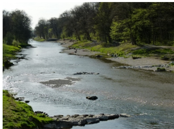
Abb. 4: Deichrückverlegung mit Uferrückbau, Kieseinbringung und Errichtung einer Buhne (Mangfall in Rosenheim, Oberbayern)
