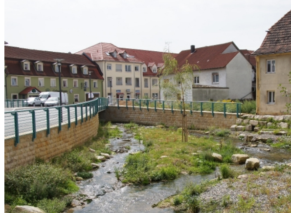
Abb. 58: Verkleidung einer Hochwasserschutzwand im Ortskern mit Natursandstein (Lauter in Bad Staffelstein, Oberfranken)
