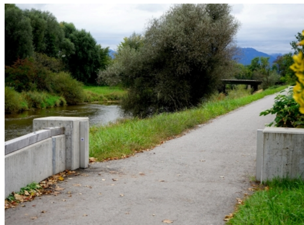
Abb. 90: Gewässerbegleitender Weg mit querender Hochwasserschutzeinrichtung (mobiles System) (Mangfall in Rosenheim, Oberbayern)
