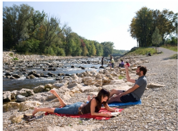
Abb. 8: Umbau eines Querbauwerks mit Entfernung von Uferverbau und Abflachung des Ufers (Wertach in Augsburg, Schwaben)
