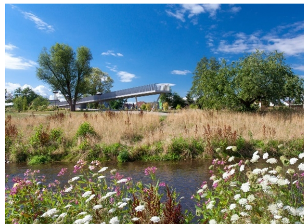
Abb. 68: Panoramasteg auf dem ehem. Gelände der Landesgartenschau (Kahl in Alzenau, Unter-franken)
