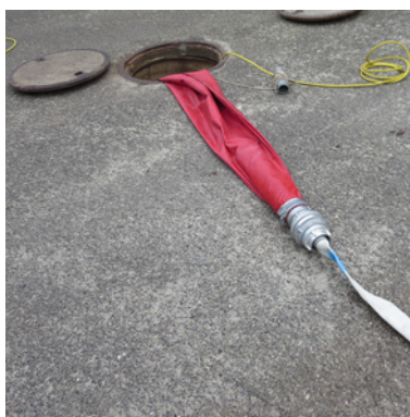
Abb. 7: Befüllung mit Wasser
