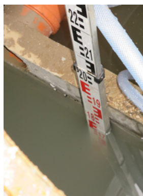
Abb. 8: Eingetauchte Messlatte zur Kontrolle des Füllstandes bis 5 cm über Rohrscheitel
