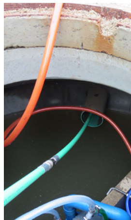
Abb. 5: Schiebestange (grün) zum Platzieren der Absperrblase
