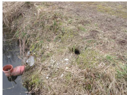
Abb. 12: Mausloch neben dem Ablauf eines Abwasserteichs
