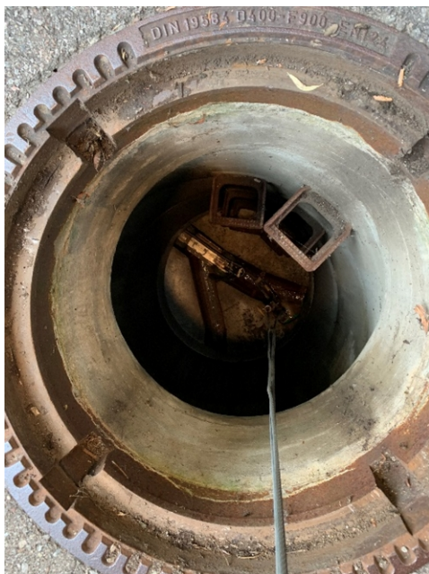
Abb. 3: Optische Inspektion mit einer Kanalkamera (über Revisionsschacht)
