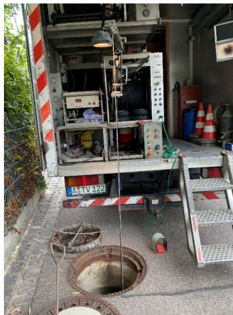
Abb. 4: Blick ins Inspektionsfahrzeug während einer Kamerabefahrung
