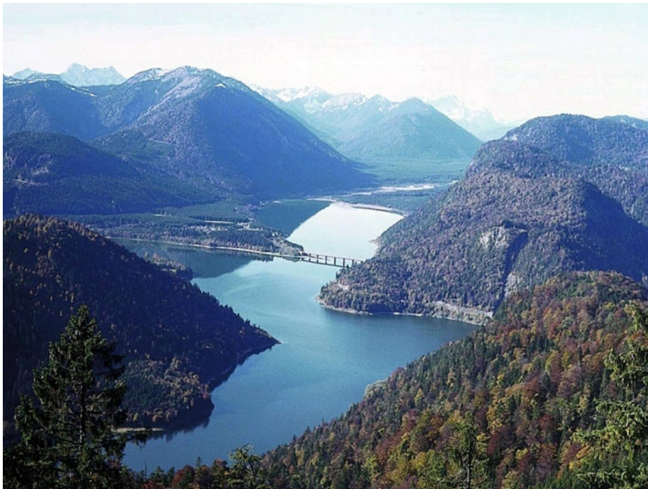
Abb. 66: Der Sylvensteinspeicher im südöstlichen Bayern.
