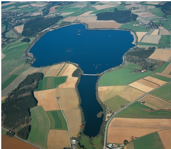
Abb. 1: Luftbild Förmitztalsperre (WWA Hof; Michael Stocker)
