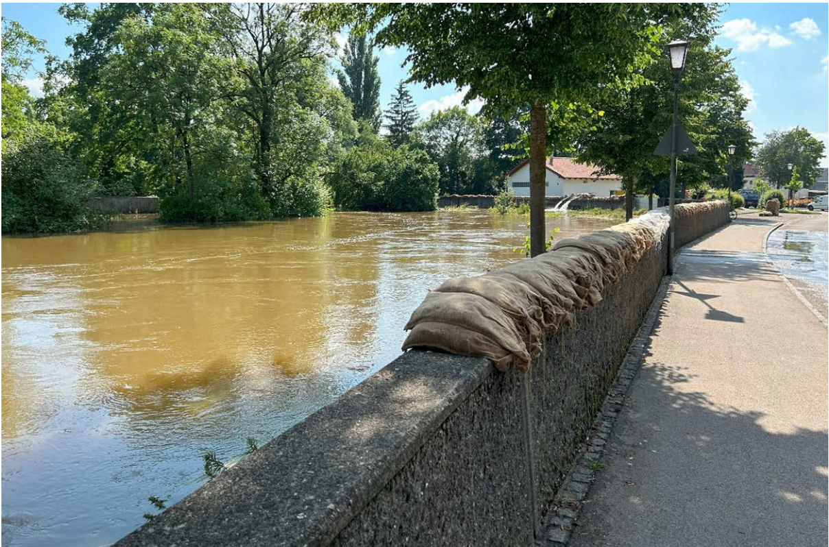
Abb. 104: Hochwasserabfluss in der Kleinen Donau am 4. Juni 2024, einen Tag nach dem Scheiteldurchgang (maximalen Wasserstand) (Foto: WWA Ingolstadt)
