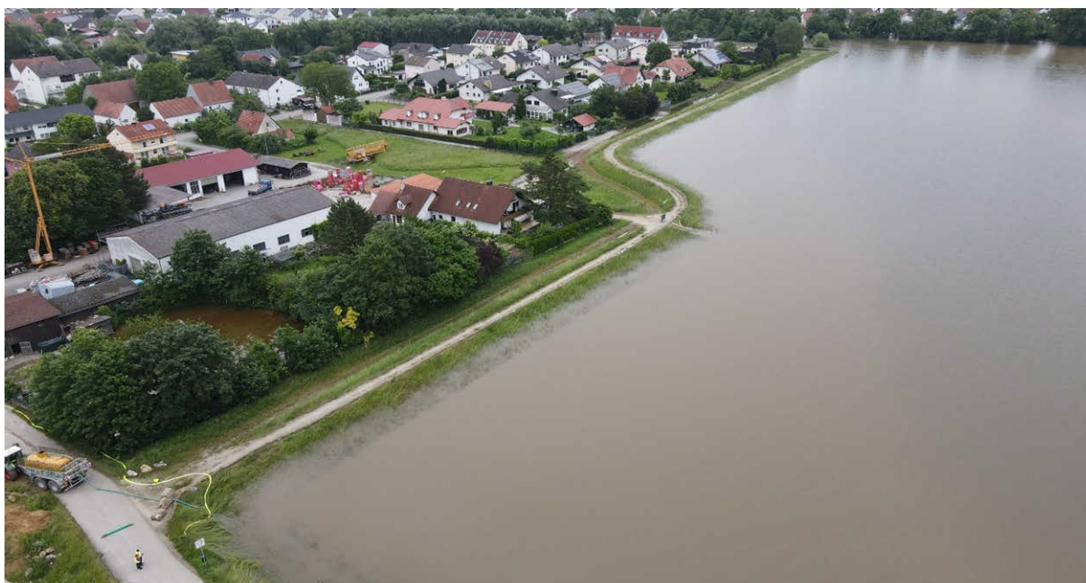
Abb. 62: Deichlinie am westlichen Stadtrand von Vohburg an der Donau (Foto: WWA Ingolstadt)
