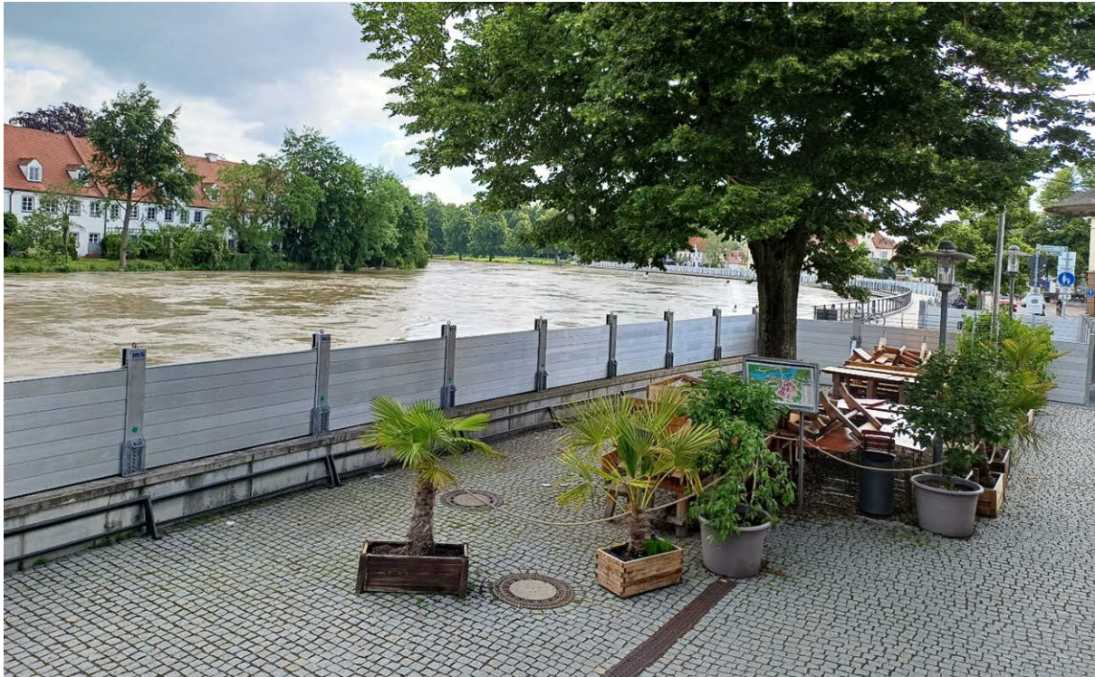
Abb. 46: Mobile Hochwasserschutzwand (HWS-Wand) in Neuburg an der Donau (Foto: WWA Ingolstadt)
