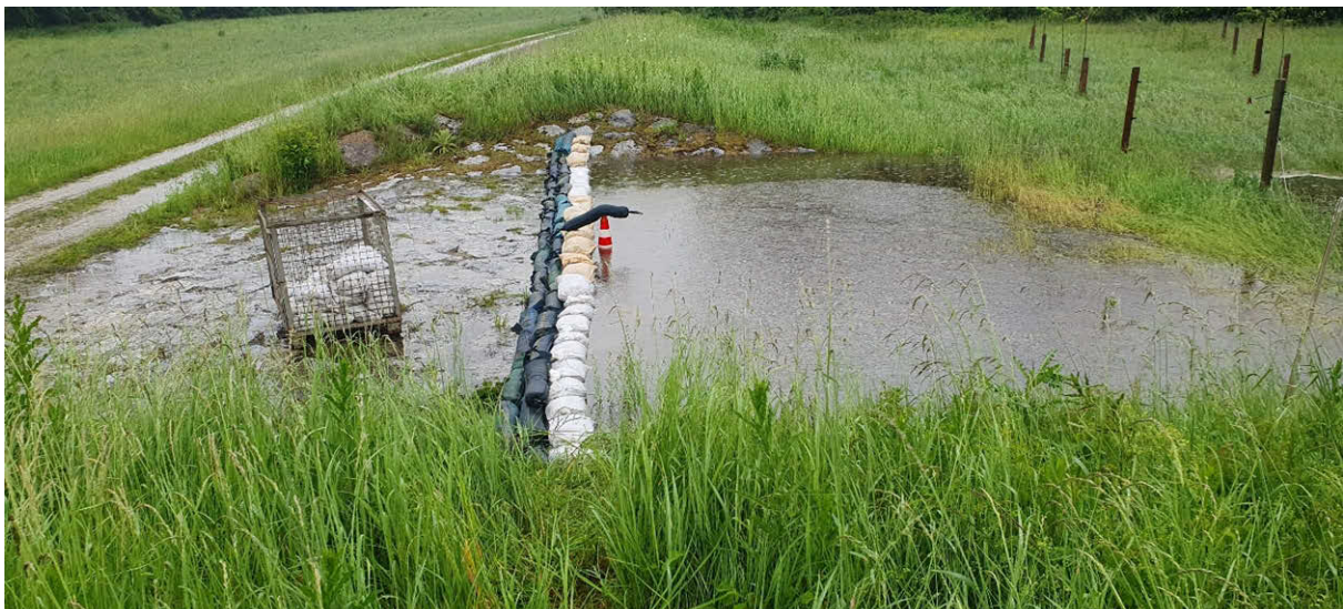
Abb. 40: Unzulässige Aufbauten/Sandsäcke auf einer Hochwasserentlastung (Foto: WWA Kempten)
