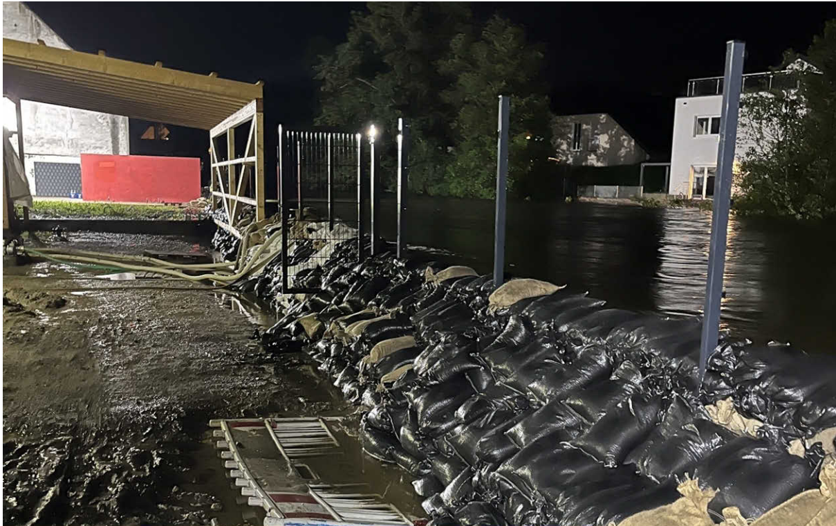
Abb. 60: Mit Sandsäcken erhöhte HWS-Wand in Manching (Foto: WWA Ingolstadt)
