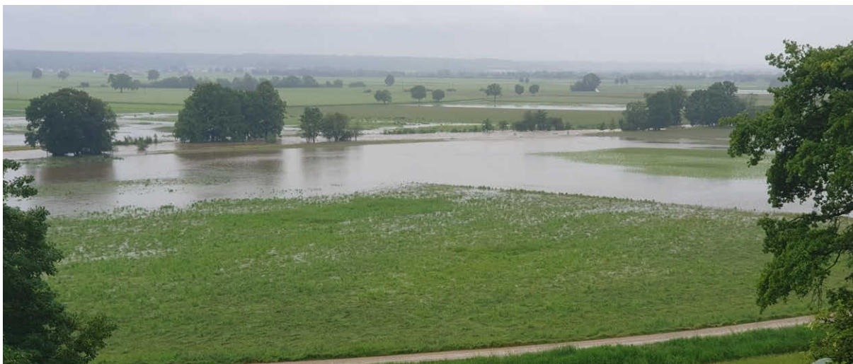
Abb. 54: Beidseitig beaufschlagter und teilweise überströmter Deichabschnitt nördlich von Mindelheim (Foto: WWA Kempten)
