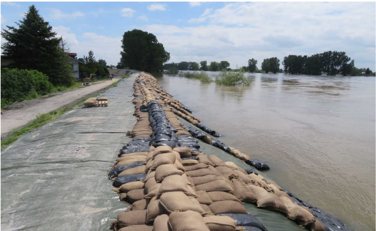
Abb. 48: Sicherung eines in Bau befindlichen Deichabschnitts bei Niederalteich (Foto: WWA Deggendorf)
