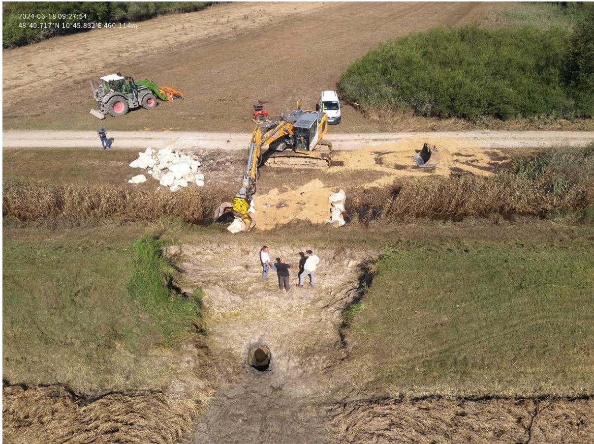
Abb. 56: Durch Biberrhre ausgelster Deichbruch bei Heiesheim (Foto: WWA Donauwrth)
