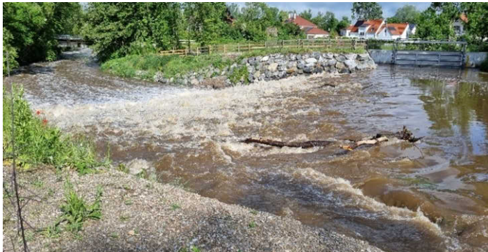
Abb. 52: Günz in Babenhausen mit Drosselbauwerk am Einlauf in den Mühlbach (Foto: WWA Kempten)
