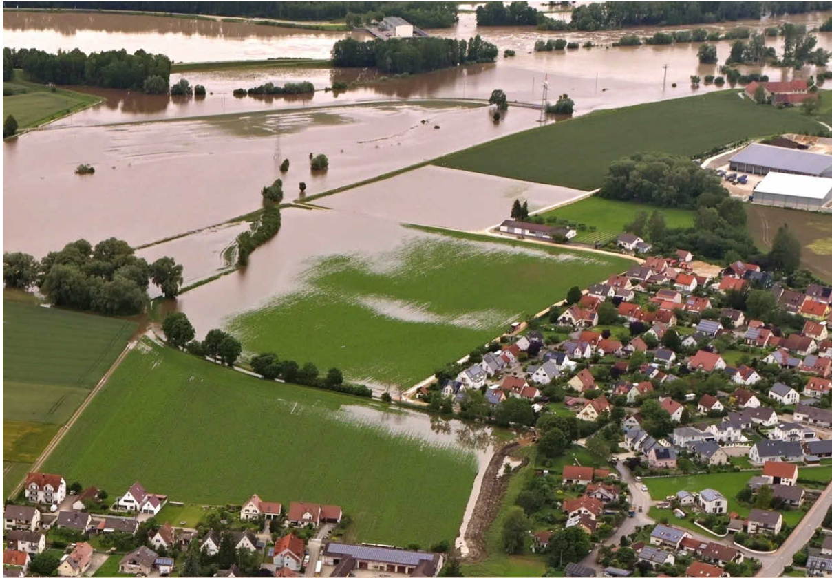
Abb. 57: Überströmter Deich bei Auchsesheim und Notdeich am westlichen Ortsrand (Foto: Hajo Dietz, Nürnberg Luftbild)
