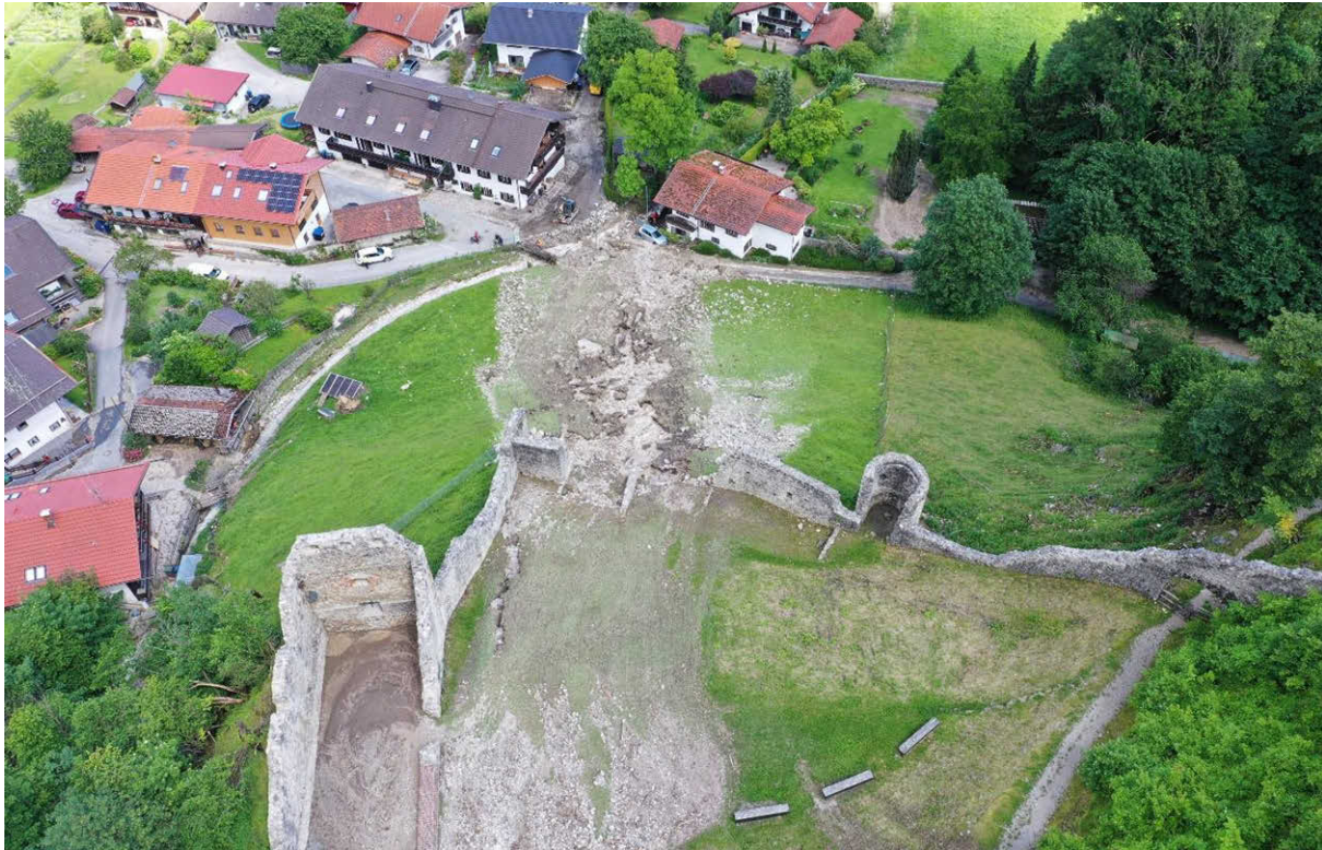
Abb. 65: Die beschädigte Burgruine Falkenstein in Flintsbach am Inn aus der Vogelperspektive (Foto: WWA Rosenheim)
