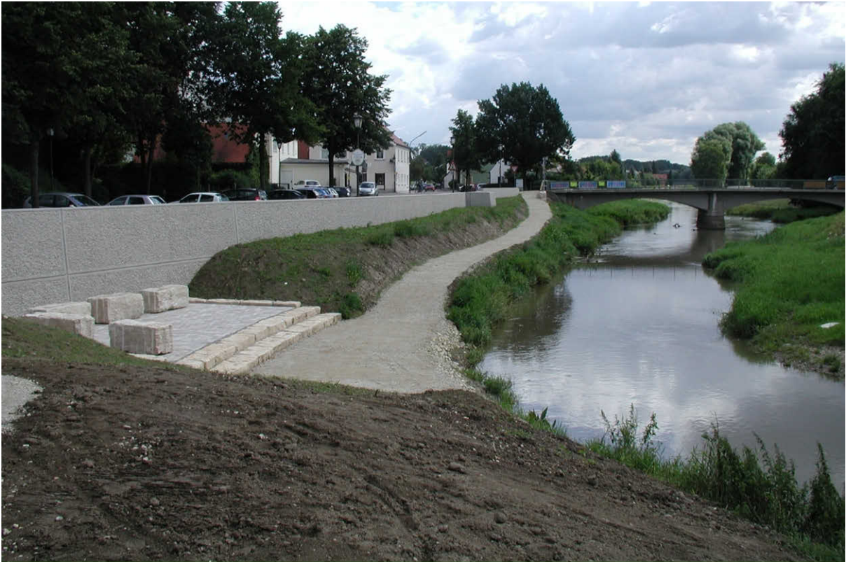
Abb. 103: HWS-Wand an der Kleinen Donau in Vohburg unmittelbar nach Fertigstellung (Foto: WWA Ingolstadt)
