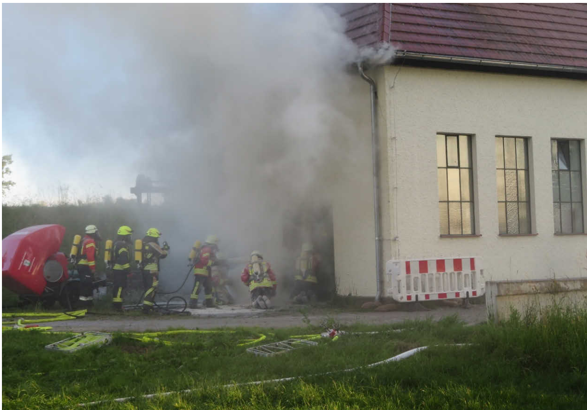
Abb. 49: Feuerwehreinsatz beim Brand des Schöpfwerks Auterwörth (Foto: WWA Deggendorf)
