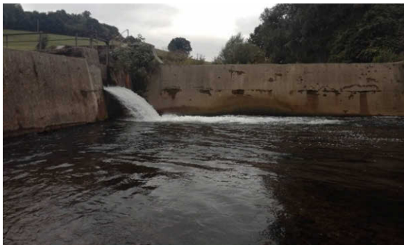
Abb. 50: Günstwehr bei Inneberg vor dem Hochwasserereignis (Foto: WWA Kempten)
