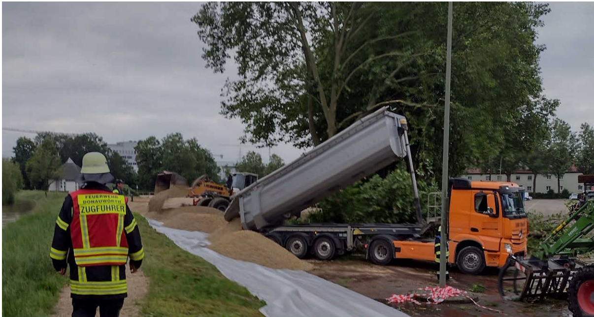
Abb. 45: Verstärkung des linksseitigen Donaudeichs östlich der Bahnlinie Donauwörth–Augsburg (Foto: WWA Donauwörth)
