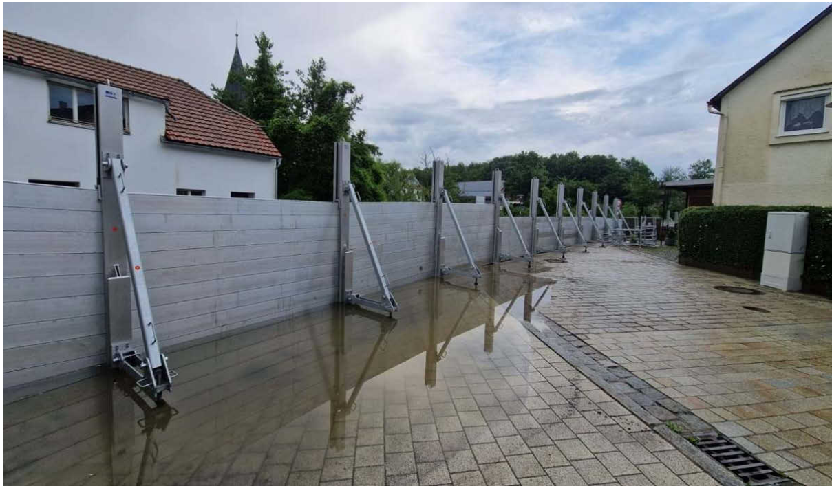
Abb. 105: Aufgestellte mobile HWS-Wand in der Donaustraße (Foto: Gemeinde Sinzig)
