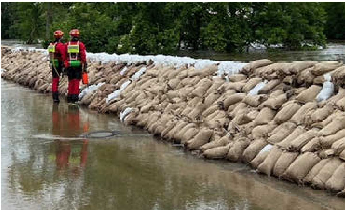
Abb. 102: Im Rahmen des Katastropheneinsatzes mit Sandsäcken verstärkte HWS-Wand in der Paarstraße (Foto: WWA Ingolstadt)
