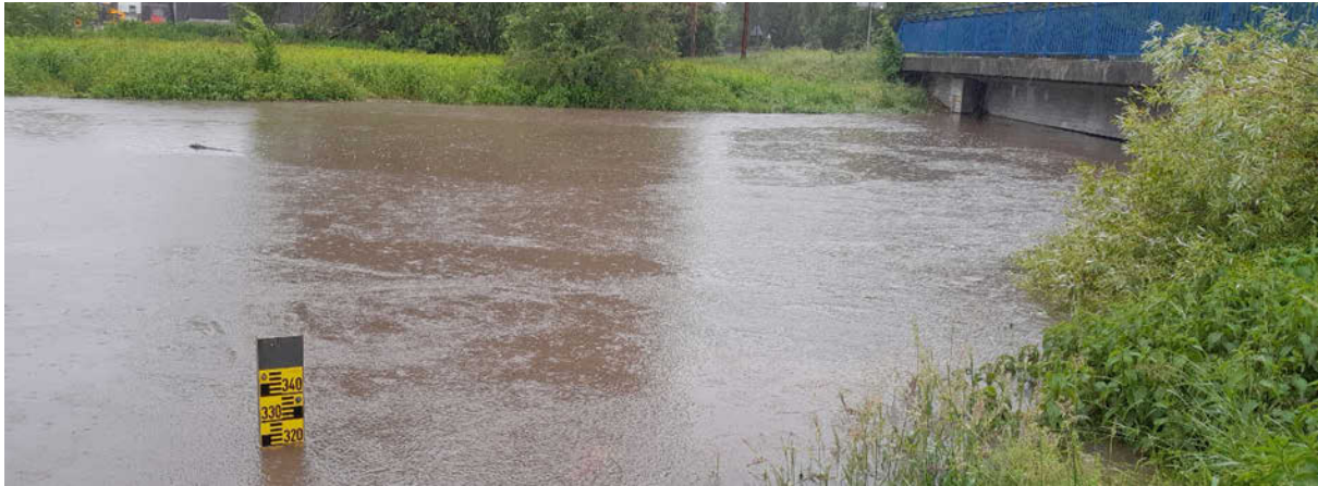
Abb. 19: Pegellatte und Abflussquerschnitt ohne Ausuferungsbereiche am Pegel Mühlried/Paar (Foto: WWA Ingolstadt)
