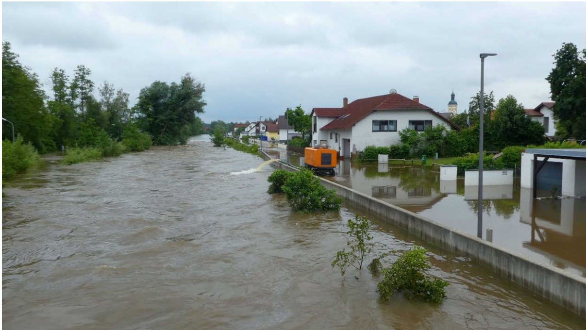
Abb. 59: Überschwemmungen in Baar-Ebenhausen (Foto: WWA Ingolstadt)
