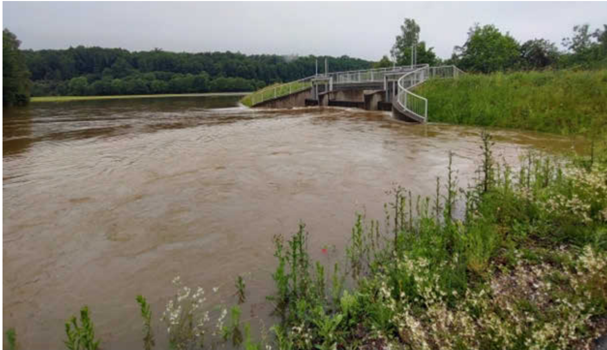
Abb. 38: Einstau des Rückhalteraums Balzhausen/Bayersried am Drosselbauwerk der Mindel (Foto: WWA Donauwörth)
