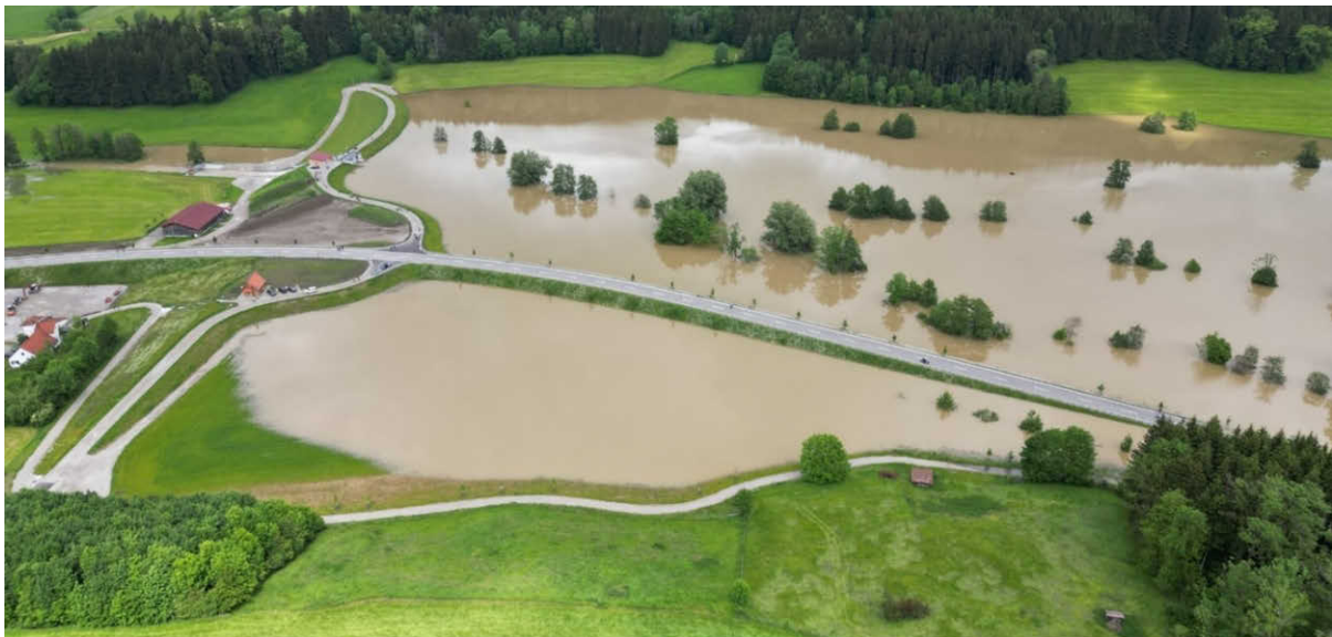
Abb. 93 und Abb. 94: Gefülltes HRB Engetried im Juni 2024 (Fotos: WWA Kempten)
