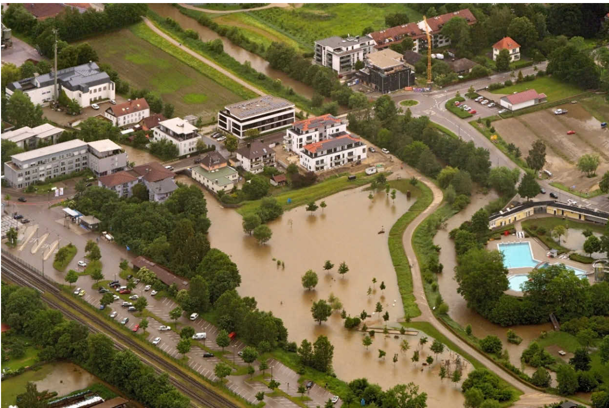
Abb. 97 und 98: Situation in Aichach beim Hochwasser 2024 – oben: Blick auf die Paar auf Höhe Gelände BC Aichach e.V.; unten: Bereich Stadtgarten/Freibad (Fotos: Hajo Dietz, Nürnberg Luftbild)
