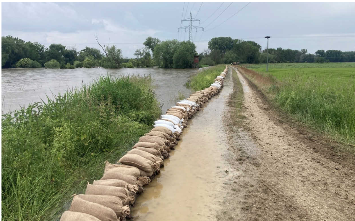
Abb. 61: Mit Sandsäcken erhöhter Deich südlich von Ilmendorf (Foto: WWA Ingolstadt)
