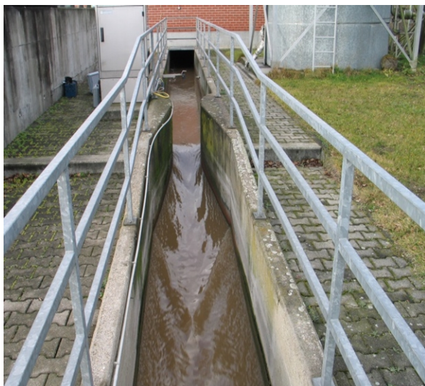
Abb. 6: Beispiel eines Venturi-Gerinnes
