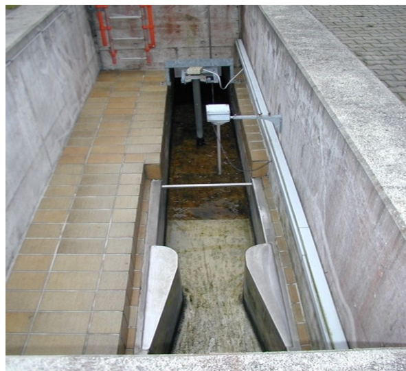
Abb. 7: Beispiel eines weiteren Venturi-Gerinnes
