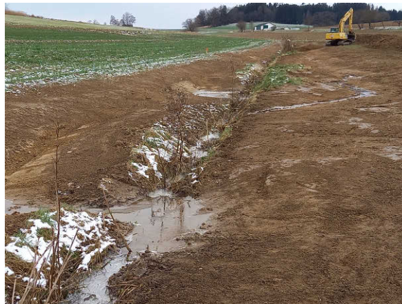
Abb. 20: Umgestaltung des Grabens mit Uferprofilierung, Schaffung von Strukturen mit Wurzelstöcken, Buhnen und Bepflanzung. Die erworbene Ackerfläche wurde mit einer Zwischenansaat begrünt.
