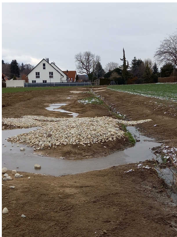
Abb. 21: Graben direkt nach Umbau mit Blick auf die Bebauung.
