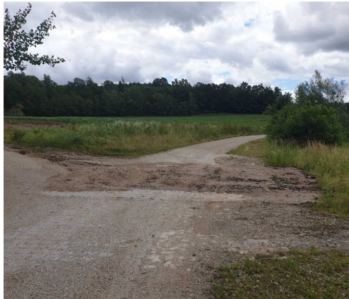
Abb. 38: Nach dem Starkregen auf dem Querweg liegendes, erodiertes Bodenmaterial. Während des Starkregens floss es von links nach rechts über den Weg in das Hochwasserrückhaltebecken 2.
