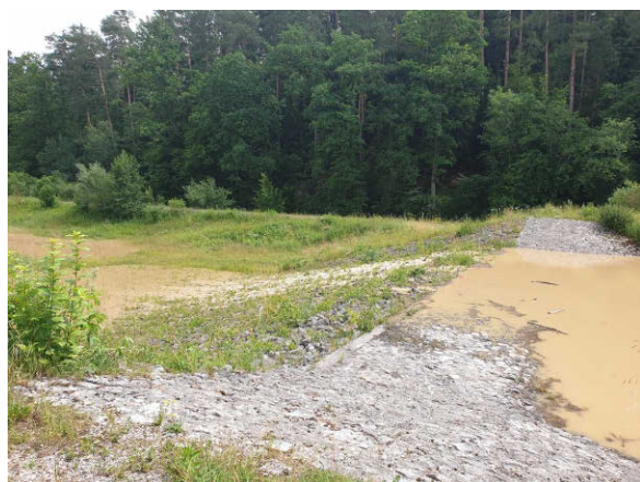
Abb. 32: Aufgrund des Geländegefälles wurden mehrere Becken hintereinander angelegt. Hier Becken 3 (li) und 4 (re) „Attenkofen“. Dadurch kann das kalkulierte Wasservolumen zurückgehalten werden.
