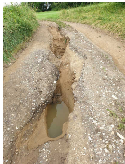
Abb. 36: Detail des erodierten und ausgespülten Wegs, Blickrichtung bergauf.
