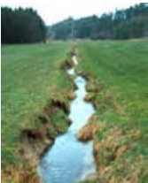
▲ Vorher: Sohl- und Ufererosion beschleunigen den Hochwasserabfluss.
