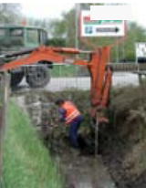
▲ Ständig wiederkehrende Sohlräumung vor einem Durchlass. Eine Brücke würde hier die Situation dauerhaft verbessern.
