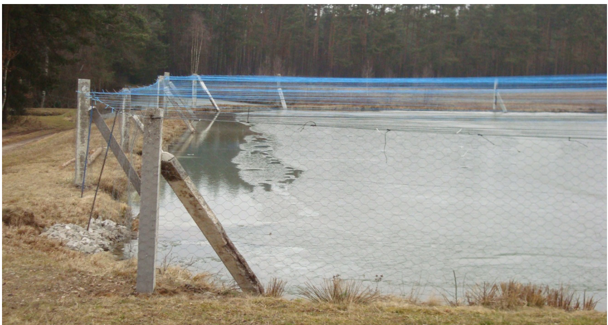
Abb. 7: Vergleichsweise dichte Fadenüberspannung mit blauen Schnüren und seitlichem Drahtgeflecht. Hier ist eine wirkungsvolle Abwehr der meisten fischfressenden Vogelarten zu erwarten. Die blauen Schnüre dürften eine hohe Abschreckungswirkung entfalten, beeinträchtigen allerdings auch das Landschaftsbild.
