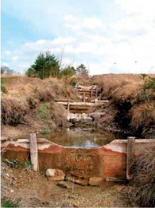
Abbildung 40 : Staukonstruktion aus Rundholz und Brettern. Die Renaturierungsproblematik entwässerter, stark geneigter Quellmoore wird deutlich. Zur Reaktivierung des ursprünglichen Überrieselungsregimes wäre ein höherer und z. T. enger gestaffelter Anstau mit Auslauf ins seitliche Gelände erforderlich. Die Dammkonstruktion ohne Torfhinterfüllung dürfte relativ rascher Verwitterung unterliegen.
