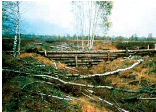
Abbildung 35: Damms stabilisierung durch Rundholzkonstruktion vor Abdichtung und Torfummantelung. (Foto R. STROHWASSER).
