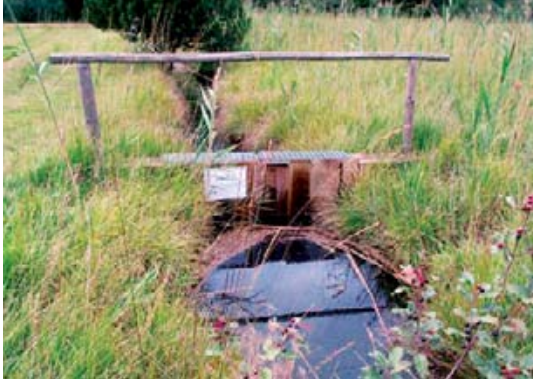
Abbildung 20: Probestau am tiefen gelegten Fügsee-Auslauf.
