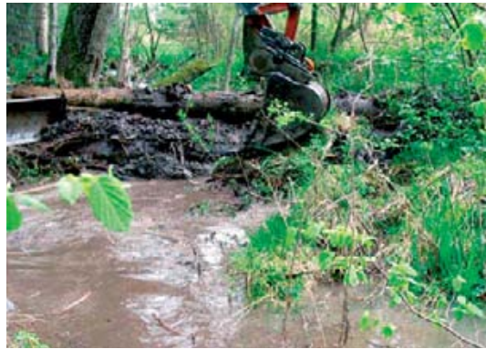
Abbildung 34: Damm mit stabilisierenden Querhölzern an einem eingetieften Quelltrichter mit starkem Wasserandrang.
