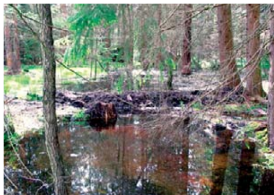
Abbildung 36: Kombiniertes Holz-Torfbauwerk mit seitlichem Überlauf (im Bild links). Ziel der Maßnahme ist die Anhebung des Wasserspiegels eines ehemaligen Quellsees durch Aufstau des stark eingetieften, von Druckwasser gespeisten Abflufs. Bei starkem Wasserandrang ist zur Vermeidung von Erosion darauf zu achten, dass der Abfluss das Bauwerk über den gewachsenen Boden breitflächig umfließt. Der Wasserspiegel wurde um ca. 1 Meter angehoben, die Maßnahme führte zum flächigen Absterben der Fichten.
