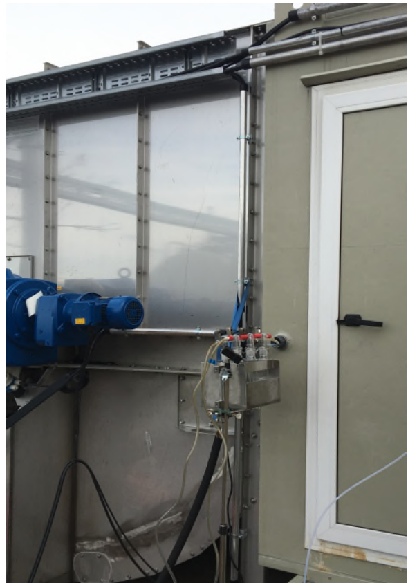
Abb. 25: Roh-gasmesssstelle Anlage A nach Betreiber Anlage A (2019)
