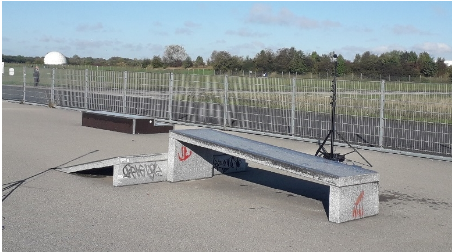
Abb. 38: Bank mit Curb – Material Granit
