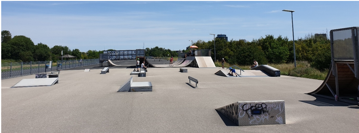
Abb. 56: Skatepark Neubiberg – Gesamtanlage
