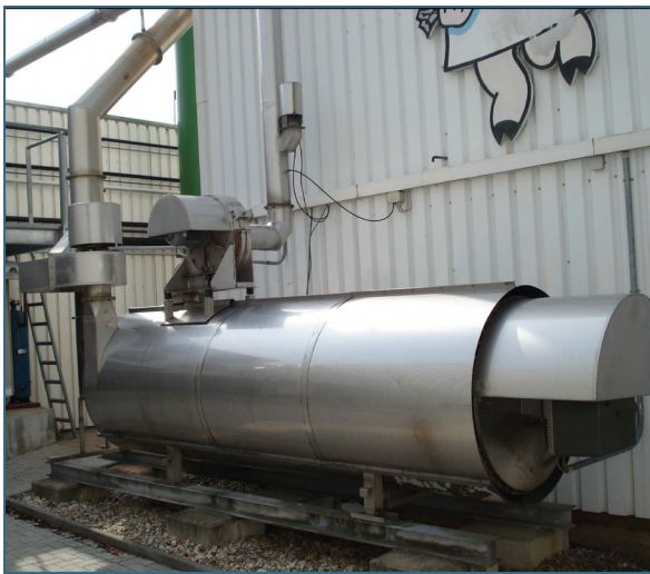
Abb. 11: Thermische Nachverbrennung von Räucher- rauch
