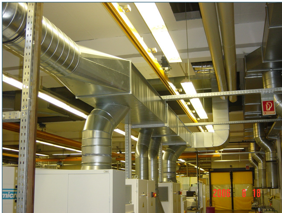
Abb. 13: Die Abwärme wird an der Wärmequelle gefasst.
