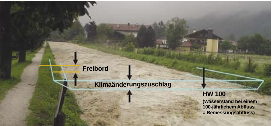
Der Klimaänderungsfaktor: Ein Zuschlag von 15 % auf den hundertjährigen Hochwasserabfluss (HQ 100 ) bei der Bemessung von Hochwasserschutzanlagen berücksichtigt den möglichen Einfluss des Klimawandels
