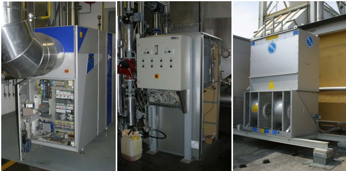
Abbildung 3.8: Trigeneration-Anlage in Graz-Thondorf (Österreich): Mikrogasturbine mit geöffnetem Schaltschrank (links), geöffnete Absorptionskältemaschine (mitte), Kühlturm auf dem Dach (rechts)
