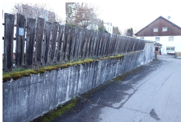
Abb. 20: Innerhalb einer Rutschung stark verkippte Mauer im Landkreis Landsberg am Lech, die auf oberflächennahe Aktivität schließen lässt.
