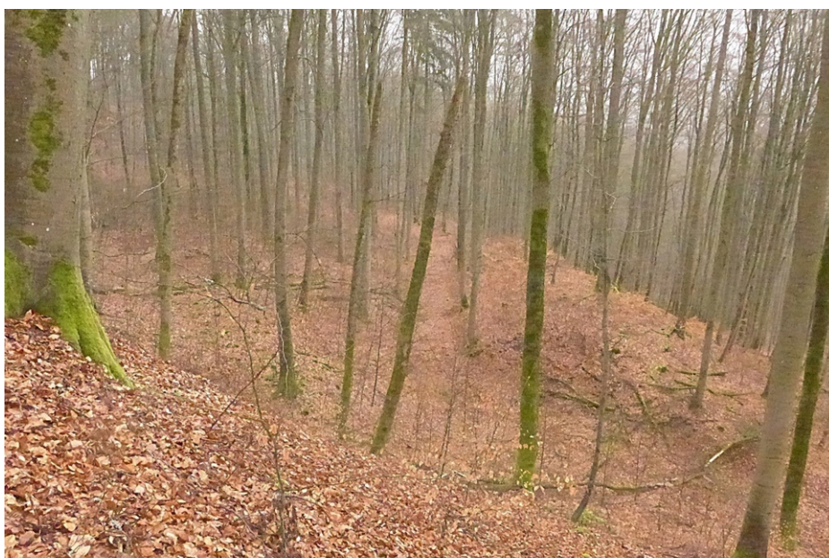
Abb. 11: Blick über die seitliche Anbruchkante einer tiefreichenden Rut- schung östlich Mur- leinsnest; rechts im Bild ist die oberste Rutschscholle zu se- hen
